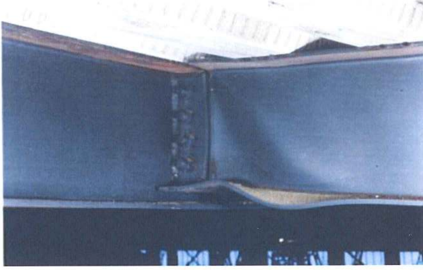
Şekil 3.31 Bölgesel burulma gösteren iç 9,0 m'lik ikincil kirişin fin plakası bağlantısı
