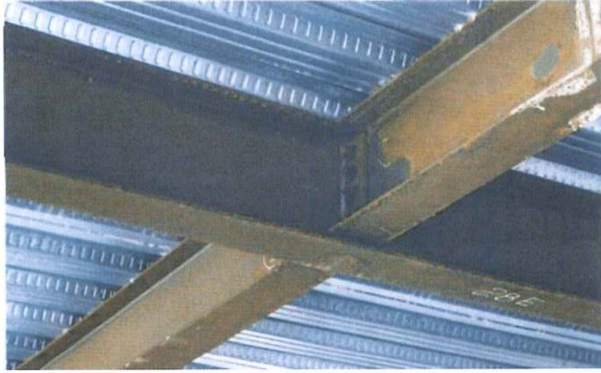
Şekil 3.9 Fin plakası (kiriş-kiriş) bağlantısı
