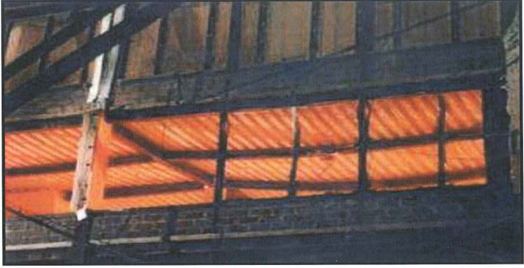
Şekil 3.48 Testin sonuna doğru yapısal davranış (ikinci iç ikincil kirişteki bölgesel burulmaya dikkat edilmeli)
