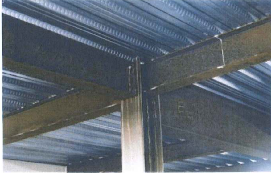
Şekil 3.10 Esnek uç plakası (kiriş-kolon) bağlantısı
