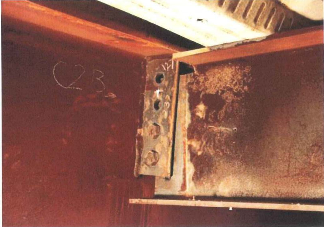
Şekil 3.22 Kiriş-kiriş birleşimlerinde (fin plakaları) civata kayması
