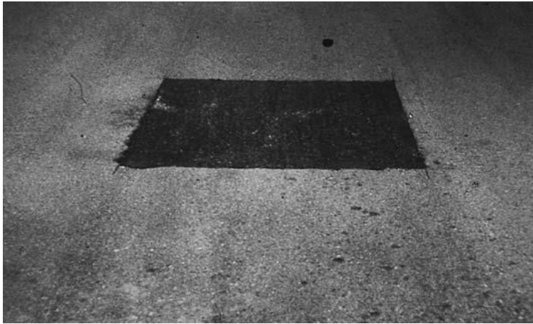
Şekil 2.23. Hafif şiddetli yama bozulması (ASTM D6433-11 2011)
