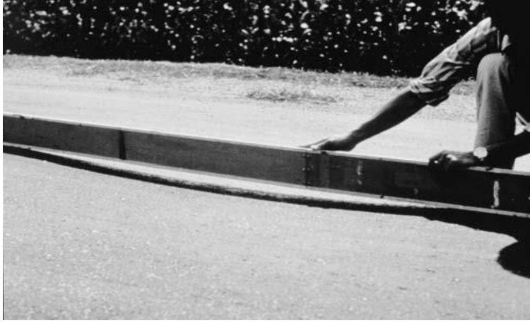
Şekil 2.18. Orta şiddetli lokal oturma bozulması (ASTM D6433-11 2011)
