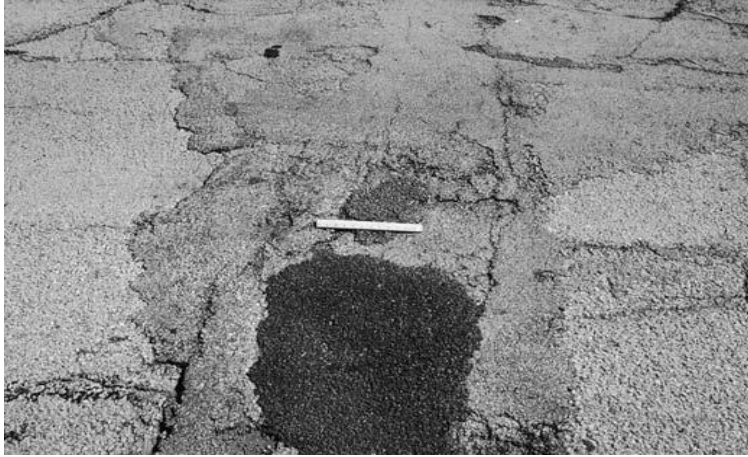
Şekil 2. 25. Yüksek şiddetli yama bozulması (ASTM D6433-11 2011)
