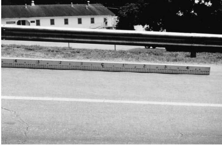
Şekil 2.14. Hafif şiddetli ondülasyon bozulması (ASTM D6433-11 2011)
