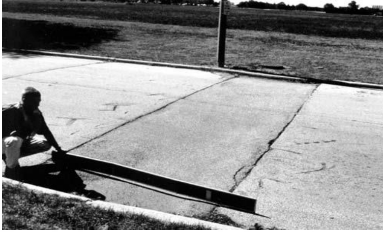
Şekil 2.24. Orta şiddetli yama bozulması (ASTM D6433-11 2011)
