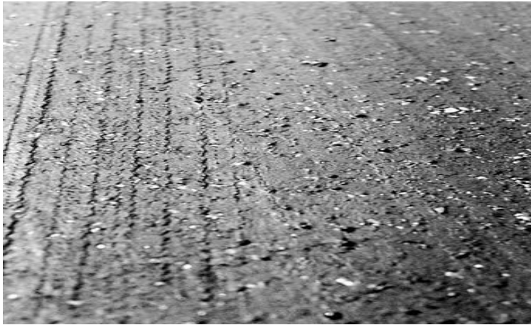
Şekil 2.12. Orta şiddetli bitümlü bağlayıcı terlemesi bozulması (ASTM D6433-11 2011)
