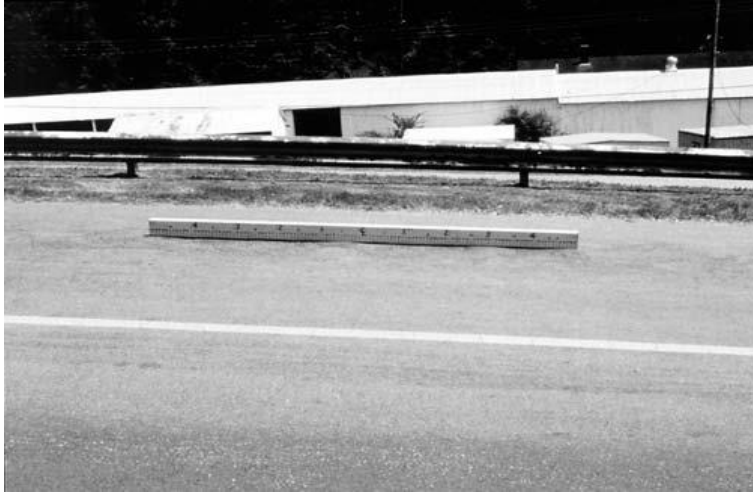
Şekil 2.15. Orta şiddetli ondülasyon bozulması (ASTM D6433-11 2011)
