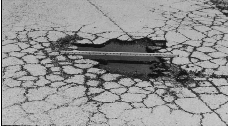
Şekil 2.22. Yüksek şiddetli çukur bozulması (ASTM D6433-11 2011)
