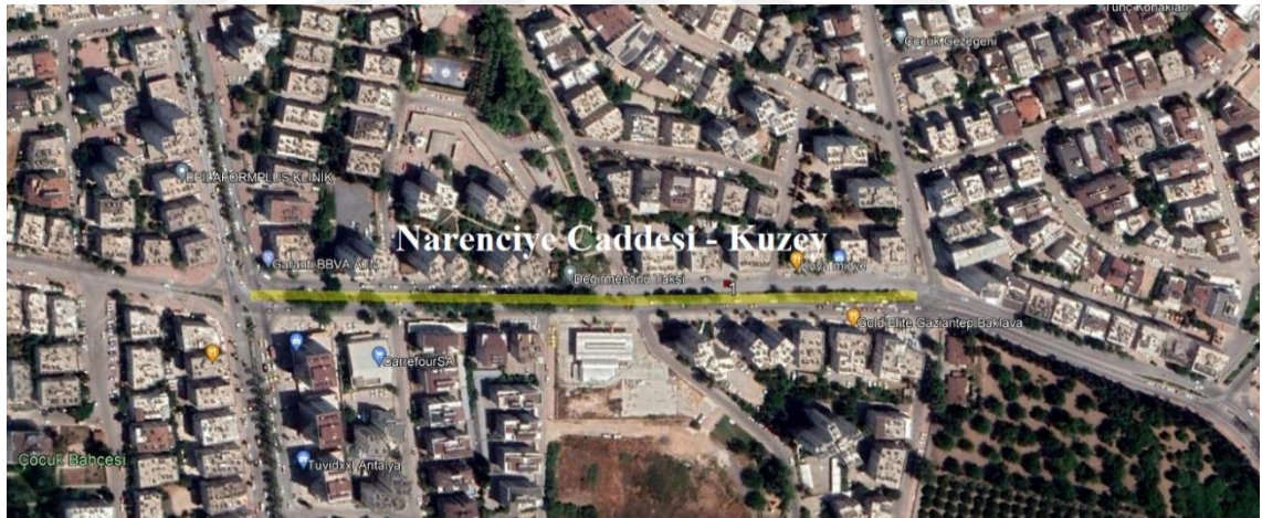
Şekil 4.22. Narenciye Caddesi kuzey kısmında meydana gelen bozulmaların harita üstünde görünümü
