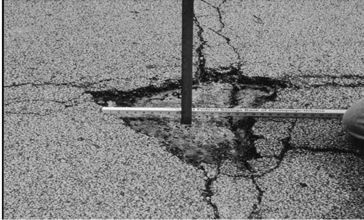
Şekil 2.21. Orta şiddetli çukur bozulması (ASTM D6433-11 2011)
