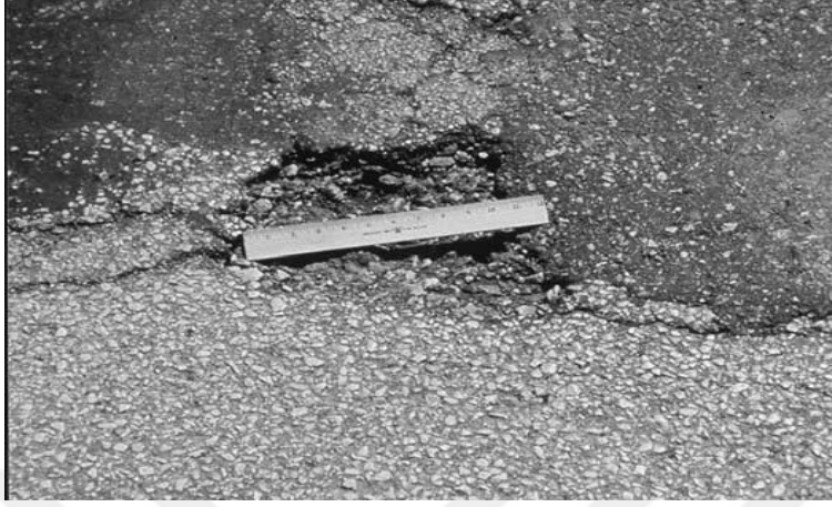
Şekil 2.20. Hafif şiddetli çukur bozulması (ASTM D6433-11 2011)
