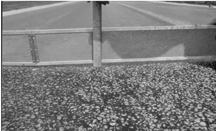
Şekil 2.27. Orta şiddetli Tekerlek izinde oturma bozulması (ASTM D6433-11 2011)
