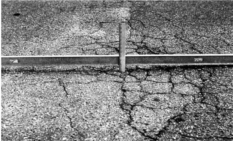
Şekil 2.19. Yüksek şiddetli lokal oturma bozulması (ASTM D6433-11 2011)
