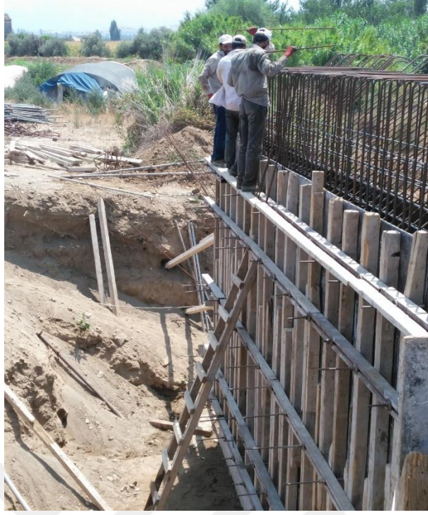
Şekil 4.11 Tamirhanedeki inşaat (Kişisel arşiv, 2019)
