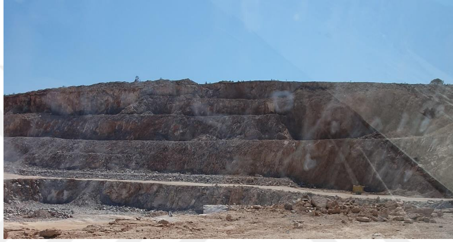
Şekil 4.6 Şev açısı, basamak genişliği (Kişisel arşiv, 2019)
