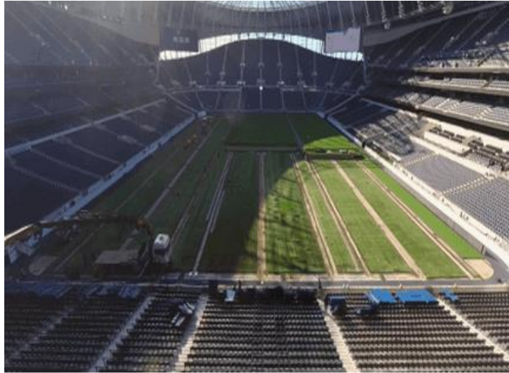
Şekil 44. Tottenham Hotspur Stadyumu Zemini Yer Değiştirirken
