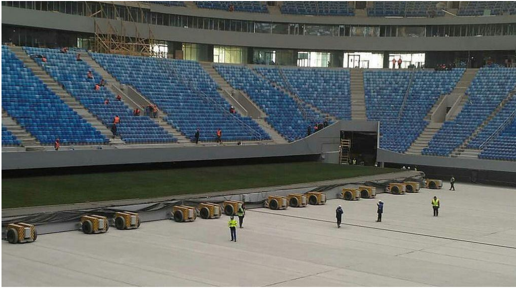
Şekil 69. Gazprom Arena Kayar Zemini
