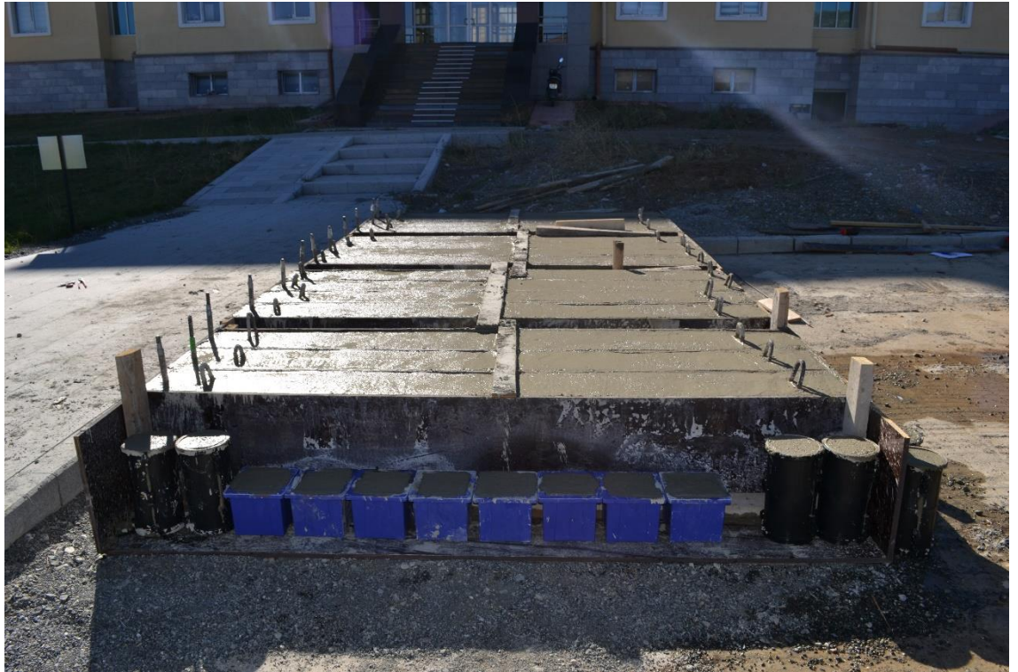
Şekil 4.11. Beton Prizi Ve Numunelerin Alımı
