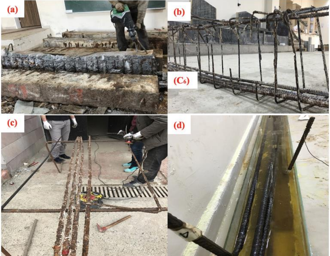
Şekil 5.3. Donatı Temizleme İşleri: (a) Beton Kırım İşleri (b) Çıkarılan Örnek Donatı (c) Mekanik Temizleme İşleri (d) Kimyasal Temizleme İşleri
