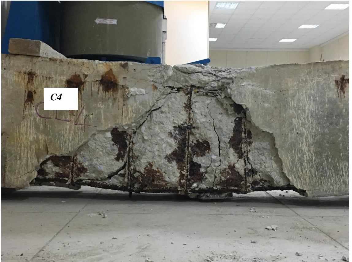
Şekil 5.20. C4 Kırım Sonrası Detaylı Çatlak Desenleri
