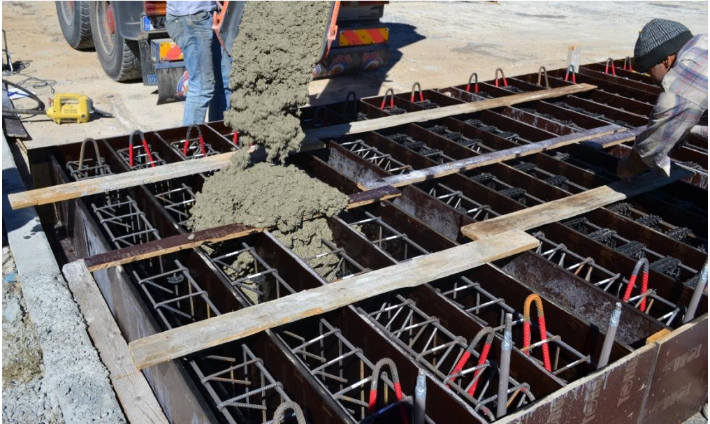
Şekil 4.9. Betonarme Kirişlerin Beton Dökümü
