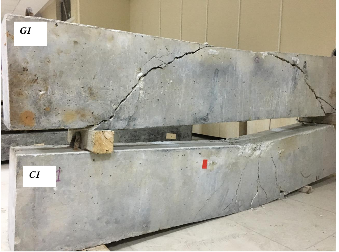
Şekil 5.15. G1 ve C1 Kırım Sonrası Çatlak Desenleri
