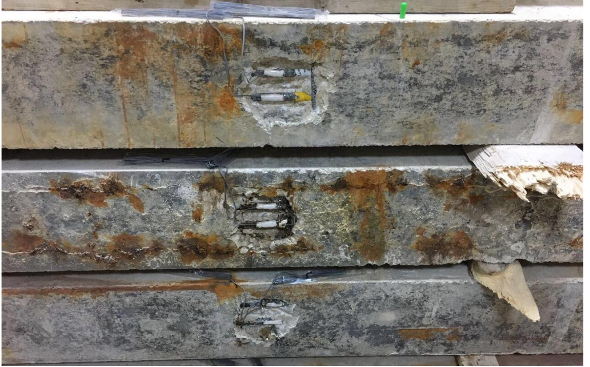
Şekil 4.14. Gerinim Ölçerlerin Yerleştirilmesi
