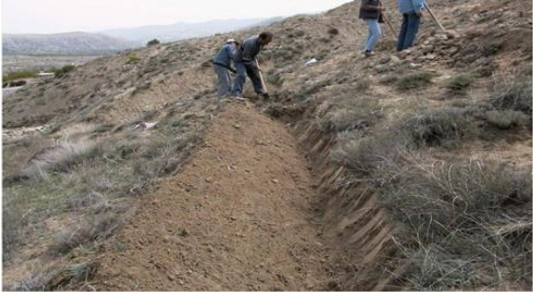
Şekil 10. Gradoni Tipi Teras arazi uygulaması (ÇEM)
