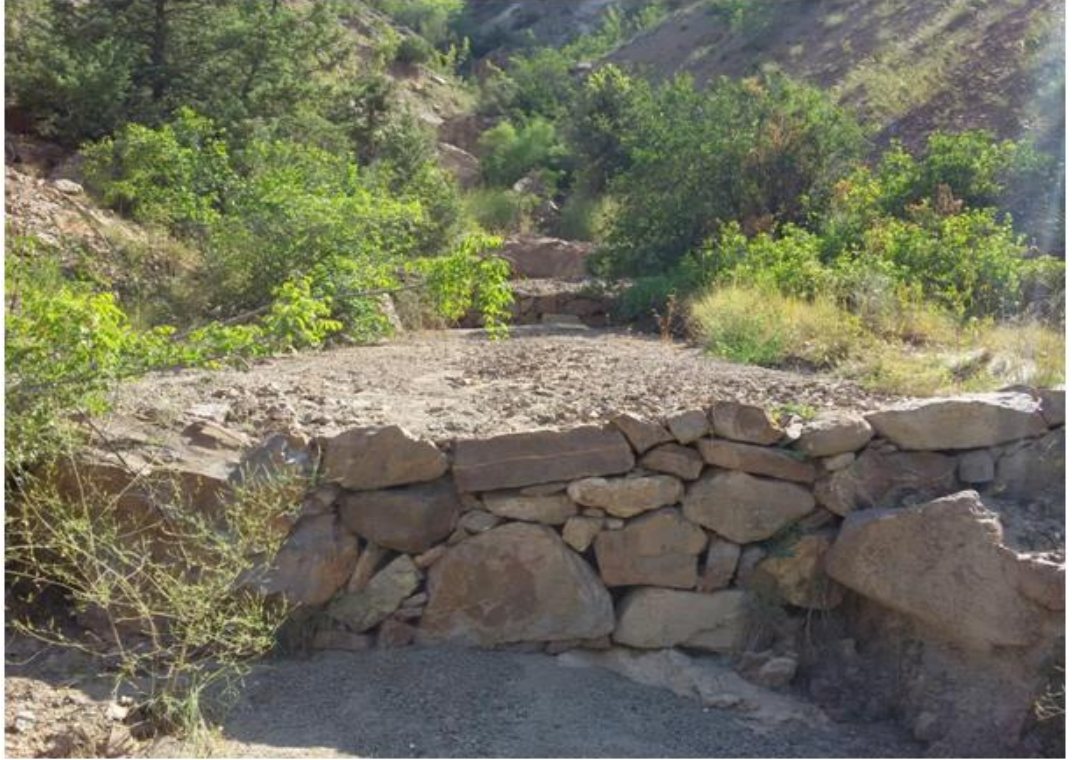
Şekil 15. Kuru duvar eşik yapım sonrası (Artvin/Yusufeli/Alanbaşı Köyü)
