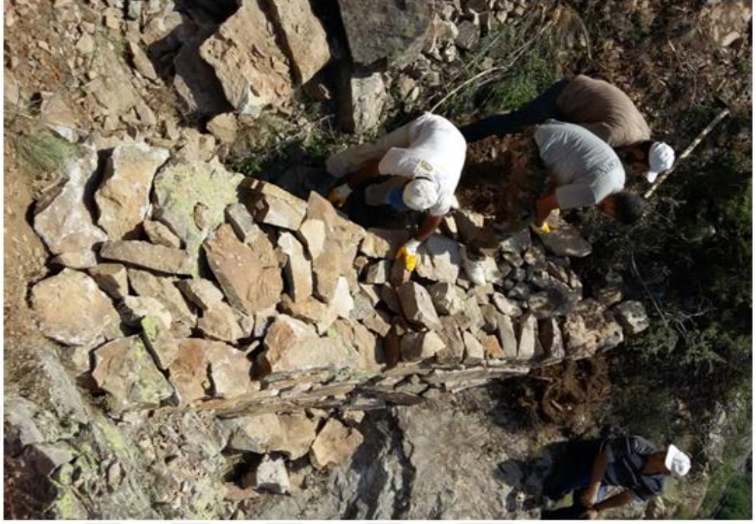
Şekil 14. Kuru duvar eşik yapımı (Artvin/Yusufeli/Altıparmak Köyü)
