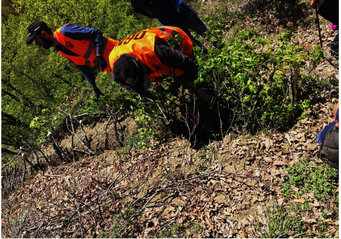
Şekil 6. Çalı takviyeli teras arazi uygulaması
