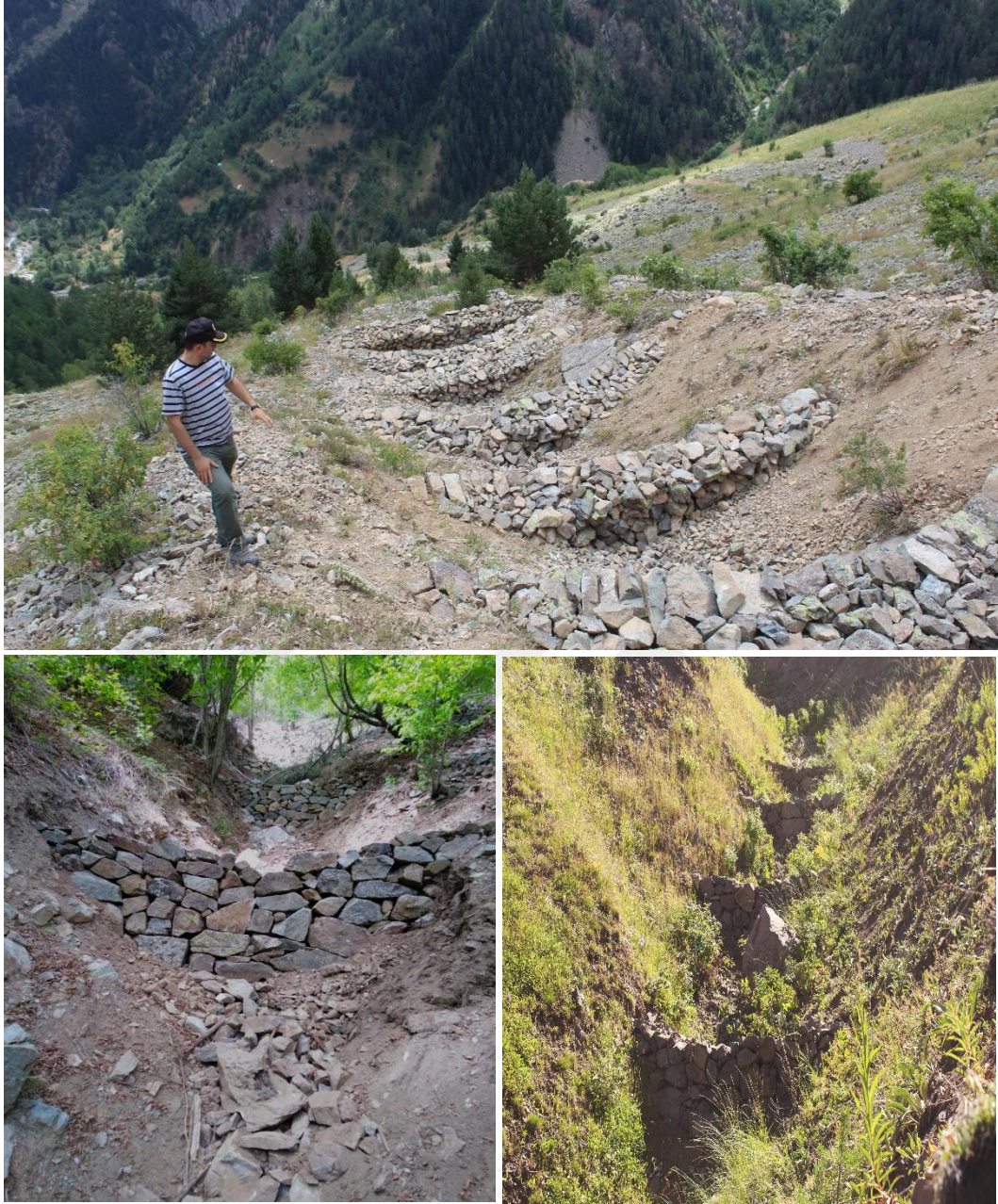
Şekil 7. Kuru duvar eşik arazi uygulaması ve ölçümü
