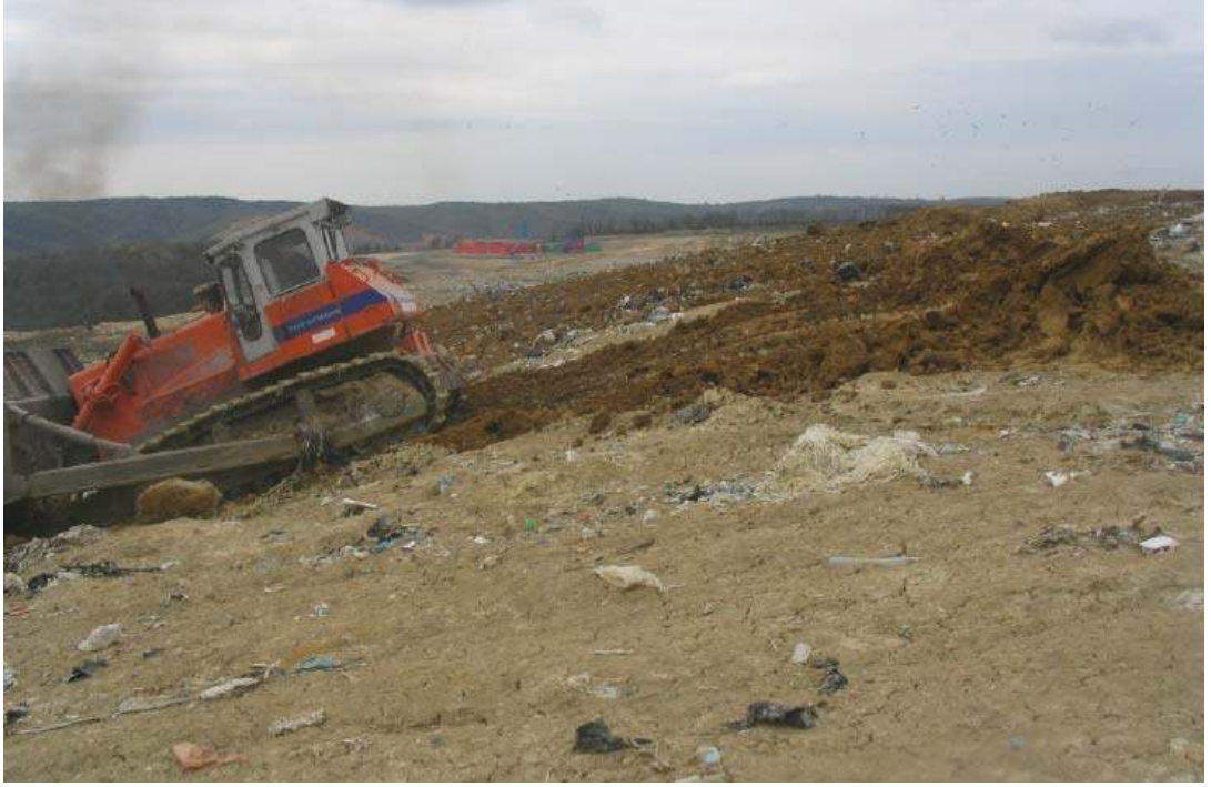
Resim 4.2. Yıpranmış örtü tabakasının ilave örtü ile tamamlanması [16]
