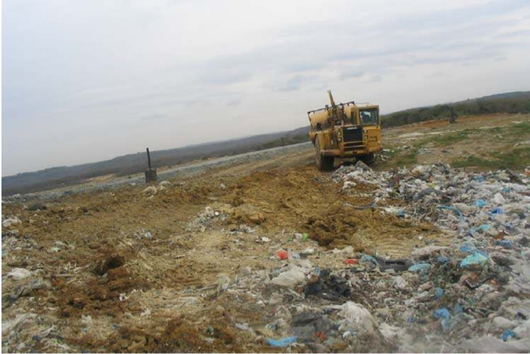
Resim 4.1. Yıpranmış örtü tabakasının ilave örtü ile tamamlanması [16].
