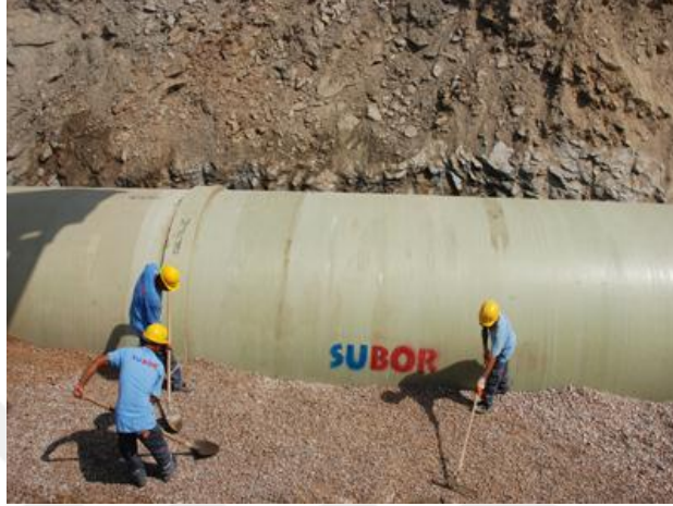
Şekil 4.1. CTP boru montajı görünümü [29]
