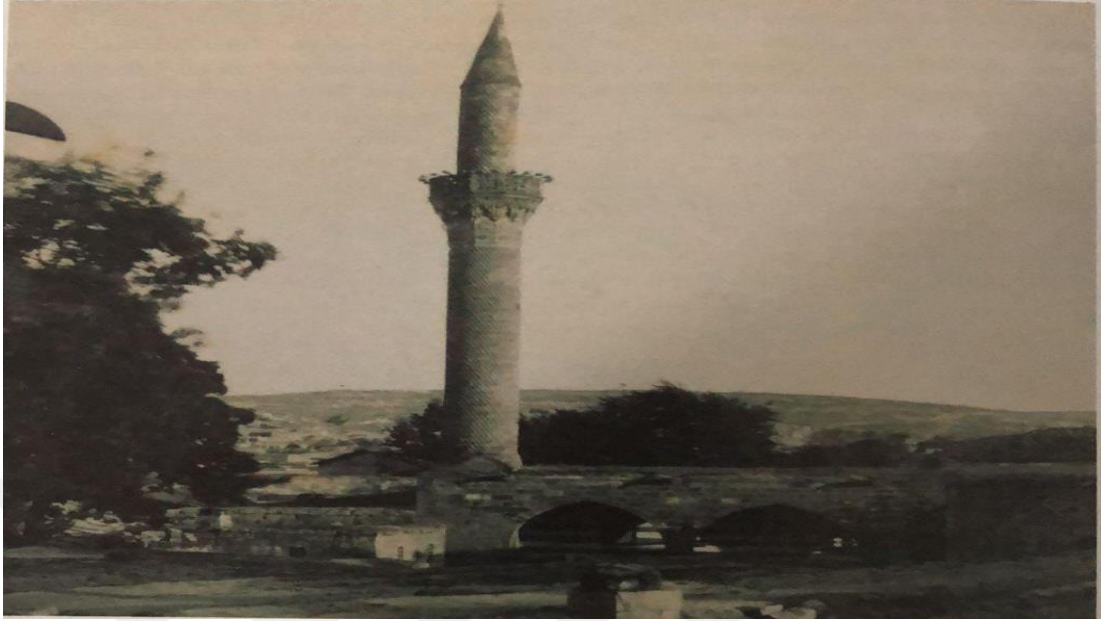
Şekil 10: Hacı Nasr Camii
