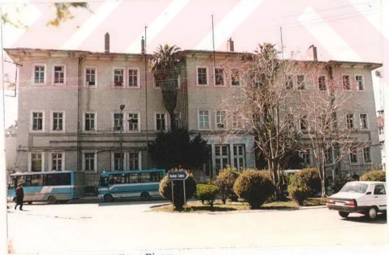
Şekil 13. Eski Vilayet Binası
