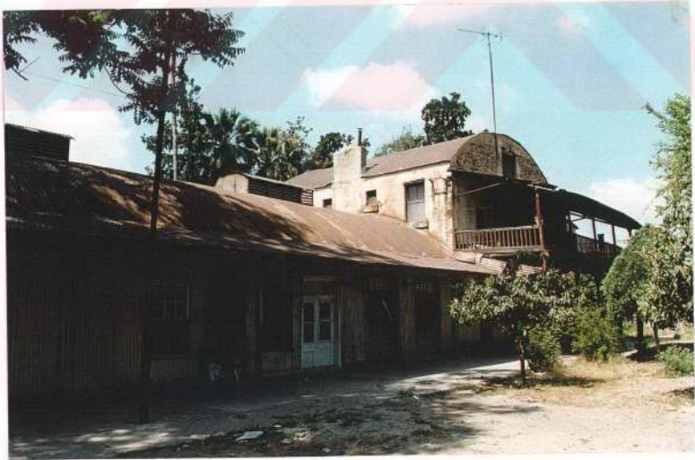
Şekil 4.7. Adana Eski İstasyon Binası
