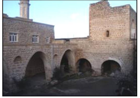
Fotoğraf 3.228 Avlunun Kuzey ve Doğu Cephesi
