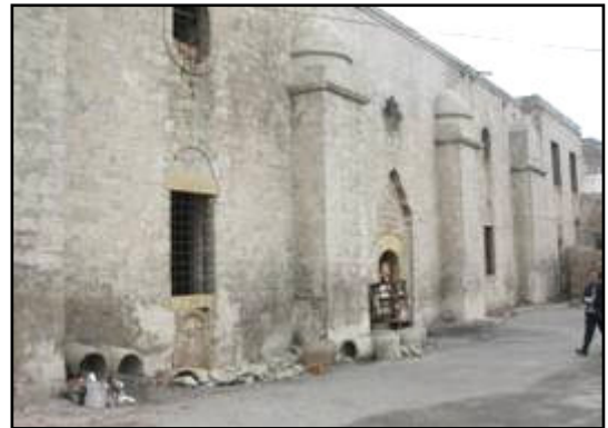
Fotoğraf 3.55 Kilisenin Güney Cephesi
