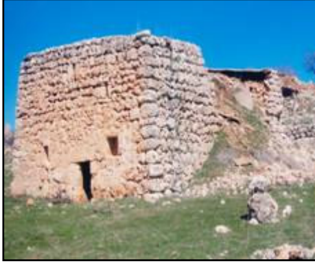
Fotoğraf 3.279 Yapının Güneybatıdan Görünümü
