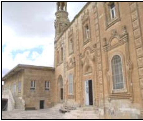
Fotoğraf 3.165 Mort Şarbel Kilisesinin Güneydoğudan Görünümü
