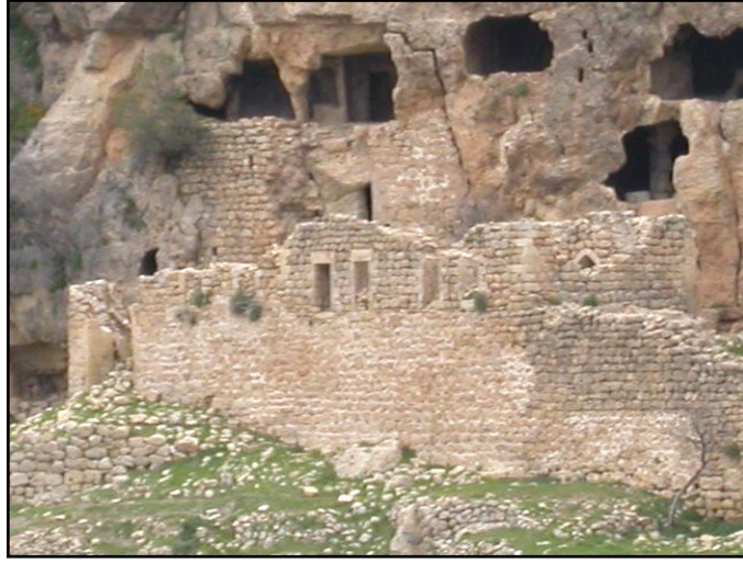
Fotoğraf 3.73 Avlu Önündeki Duvar
