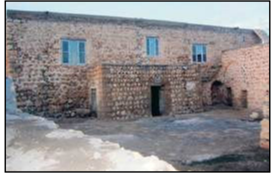
Fotoğraf 3.290 Kilisenin Güney Cephesi
