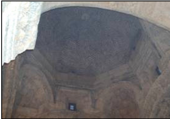
Fotoğraf 3.185 Kilisenin Kubbesi ve Kubbe Geçişleri
