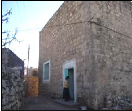
Fotoğraf 3.63 Doğu Cephesi
