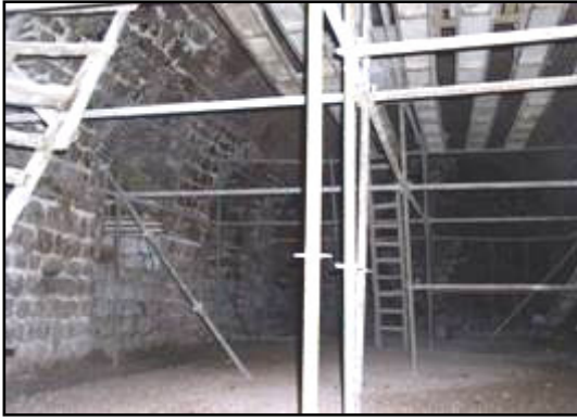
Fotoğraf 3.130 Onarımda Olan Mutfak Bölümü
