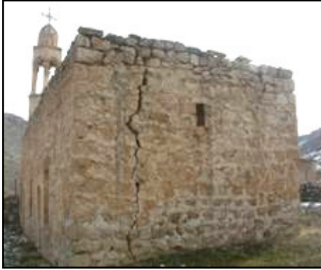
Fotoğraf 3.101 Doğu Cephesi
