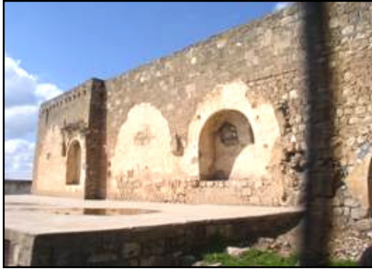
Fotoğraf 3.345 Kilisenin Güney Cephesi
