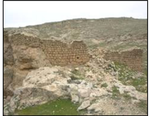
Fotoğraf 3.87 Kilise Kalıntılarının Doğudan Görünümü
