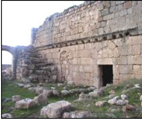
Fotoğraf 3.242 Kilisenin Güney Cephesi
