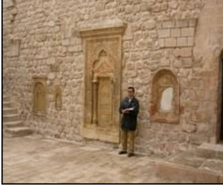
Fotoğraf 3.25 İç Avlunun Batı Cephesi
