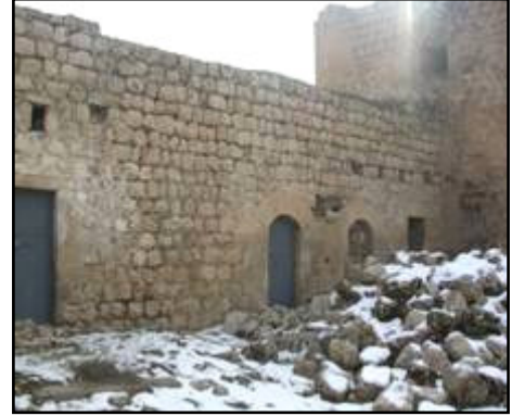
Fotoğraf 3.107 Süryani Katolik Kilisenin Güney Duvarı
