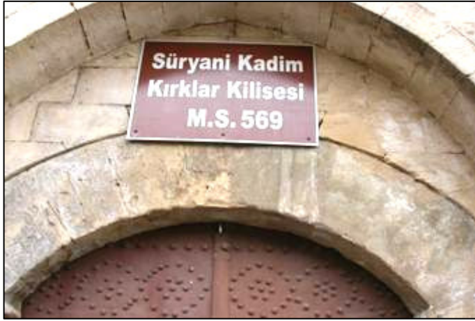
Fotoğraf 3.27 Kırklar Kilisesi Giriş Kapısı
