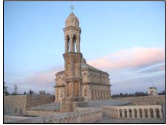
Fotoğraf 3.187 Kilisenin Çatısı ve Çan Kulesi
