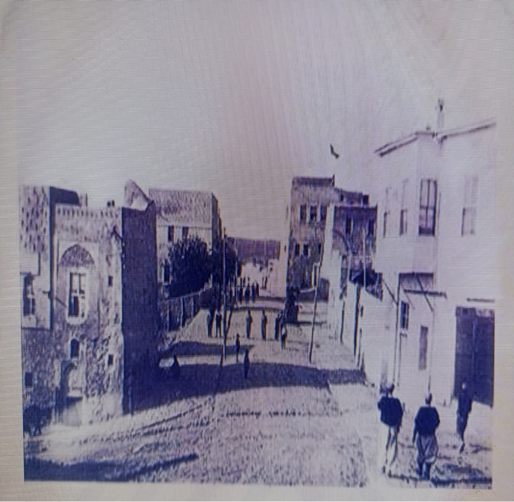
EK-2. 1930'lu yıllar Siirt Aynsalip Çeşmesinden bir görünüm
