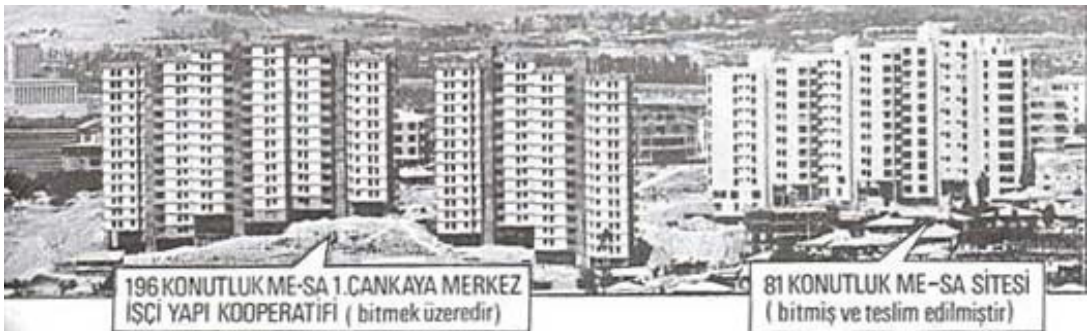
Resim 4.60. ME-SA Çankaya inşaatları [Mimarlık, 1972]
