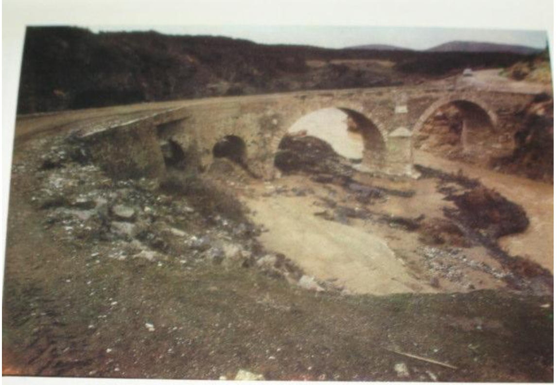
Fot. 13 — Hoca Seyfeddin Köprüsü
