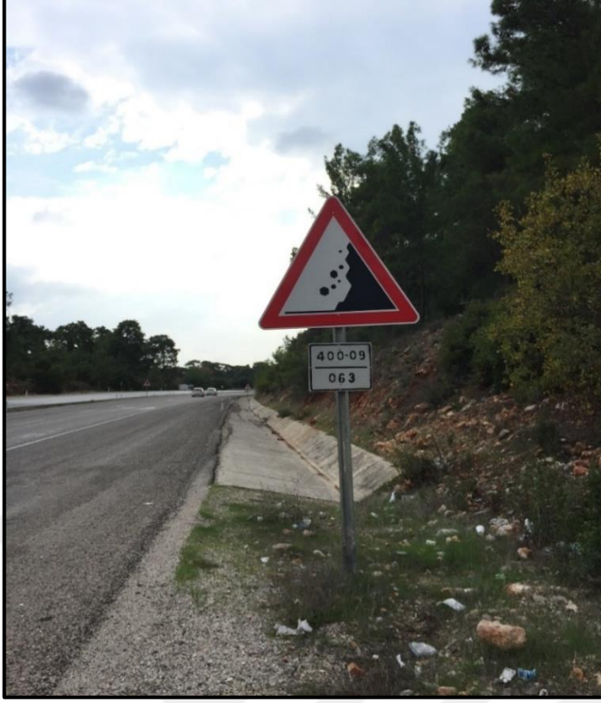
Şekil 4.3. Bölgenin kaya düşmelerine duyarlı olduğunu gösteren uyarı levhası
