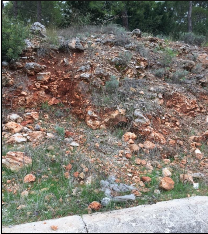
Şekil 4.4. Şevdeki kaya bloklarının detaylı görüntüsü
