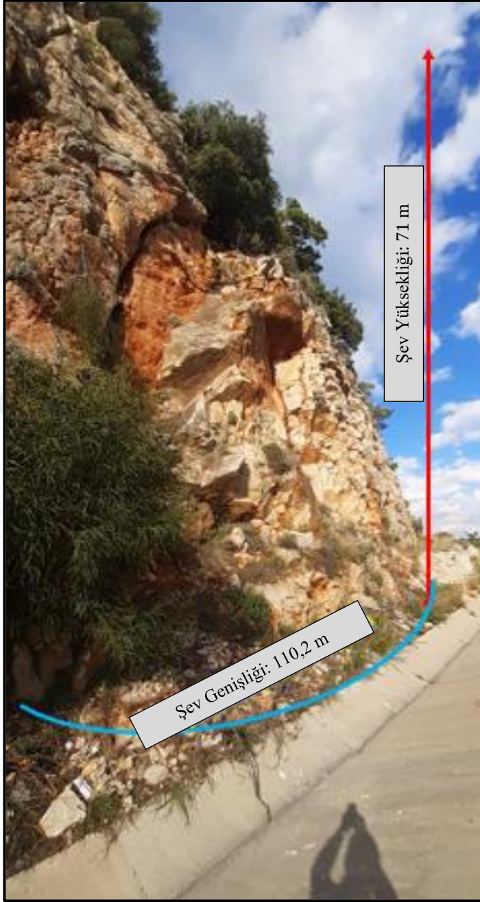
Şekil 4.15. A5-sınıfı şevine ait genel görüntü (Antalya istikameti)
