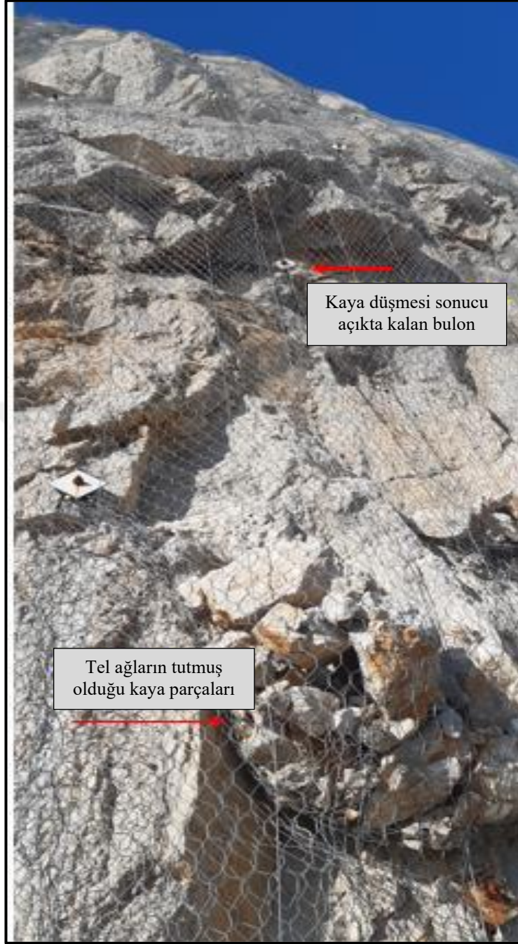
Şekil 4.11. A3-sınıfına ait şev görüntüsü
