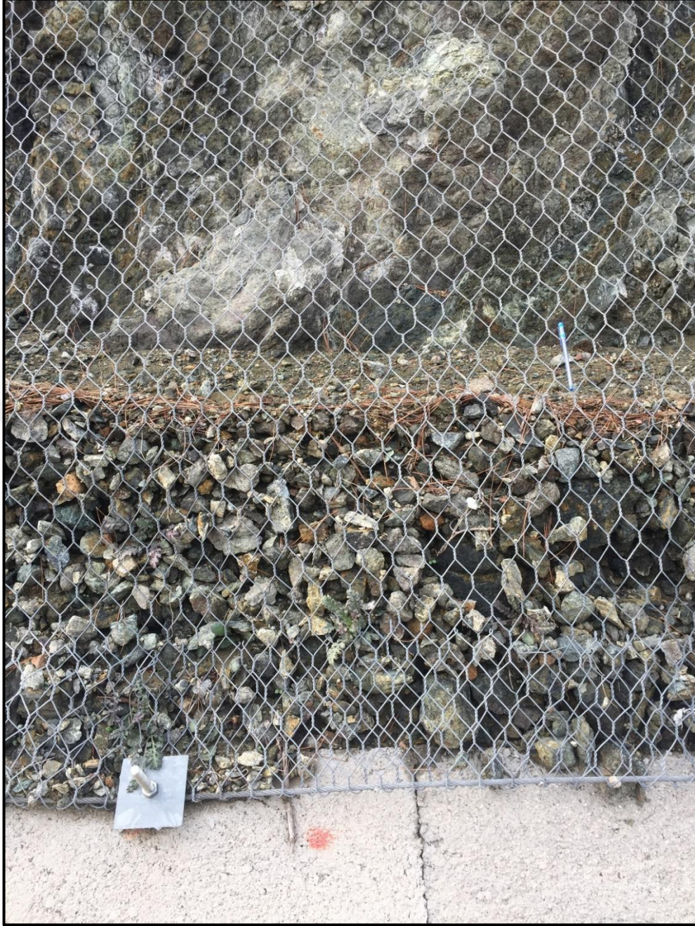
Şekil 4.10. Çelik ağda biriken malzemelerin görüntüsü
