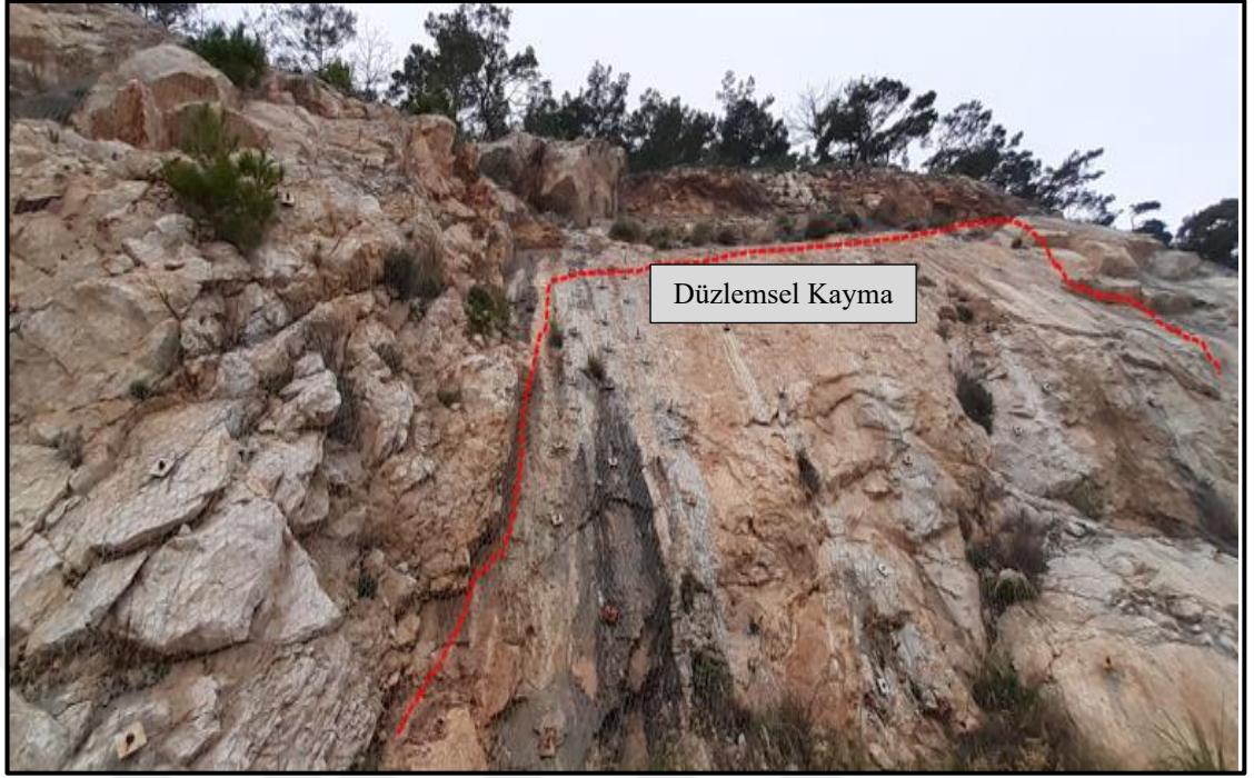
Şekil 4.8. A1-sınıfı şevinin yenilme türü ve çelik ağların görünümü
