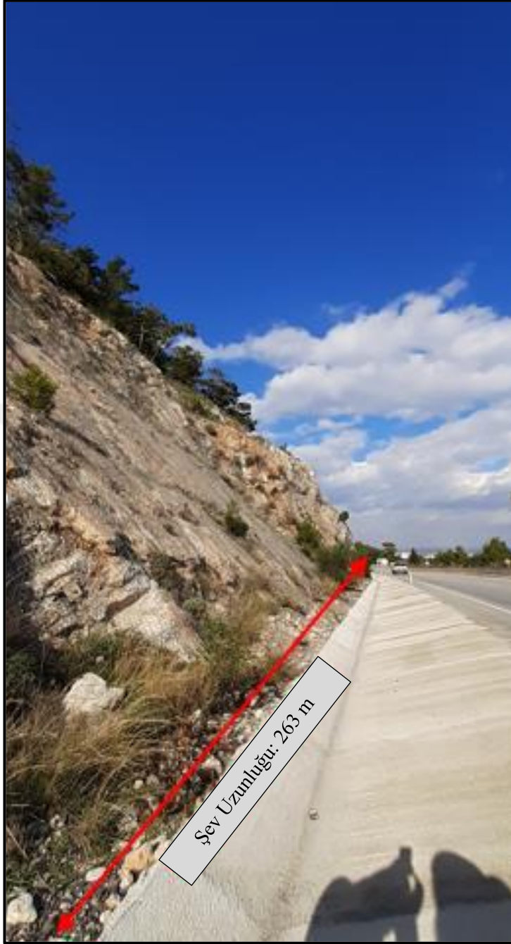
Şekil 4.7. Çalışma alanına ait 1. Bölgedeki karayolu şevinin görüntüsü
