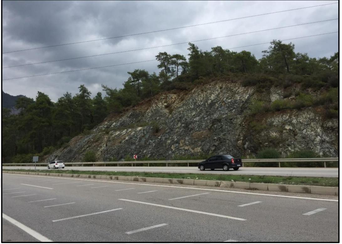
Şekil 4.17. A6-sınıfı şevin karşıdan görüntüsü
