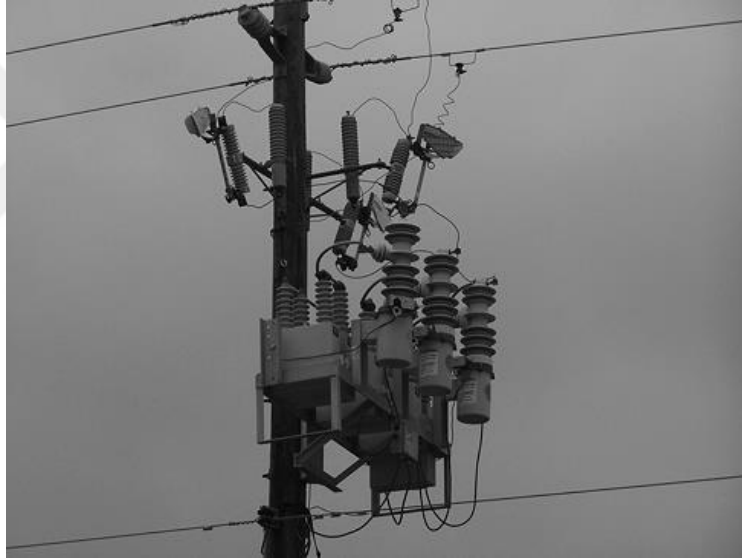
Şekil 3.13. Dağıtım fideri üzerinde bulunan direk tepesi anahtarlama kondansatör bankası [87].
