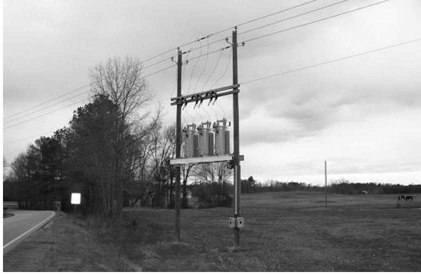
Şekil 3.7. Dağıtım fideri üzerinde bulunan üç tek fazlı gerilim regülatörü [87].
