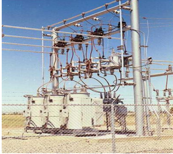
Şekil 2-15: Kapalı üçgen uygulama örneği
