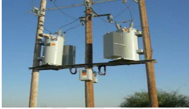
Şekil 2-17: Açık üçgen bağlantı uygulama örneği
