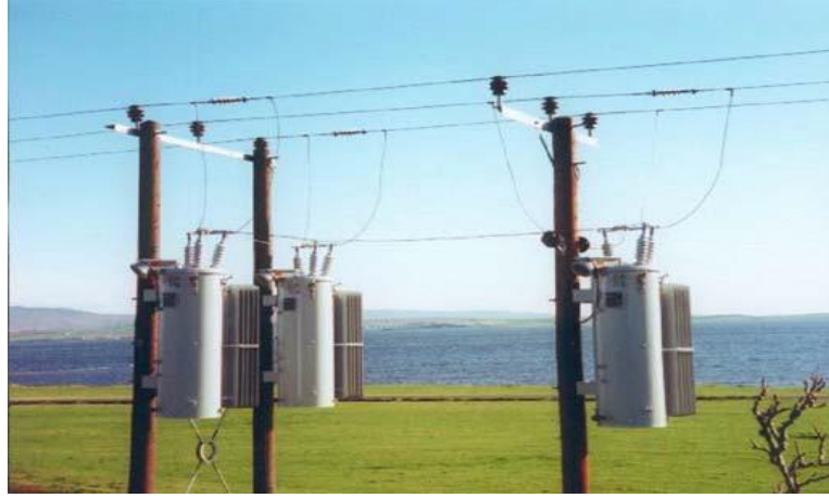
Şekil 2-13: Direk tipi uygulama örneği
