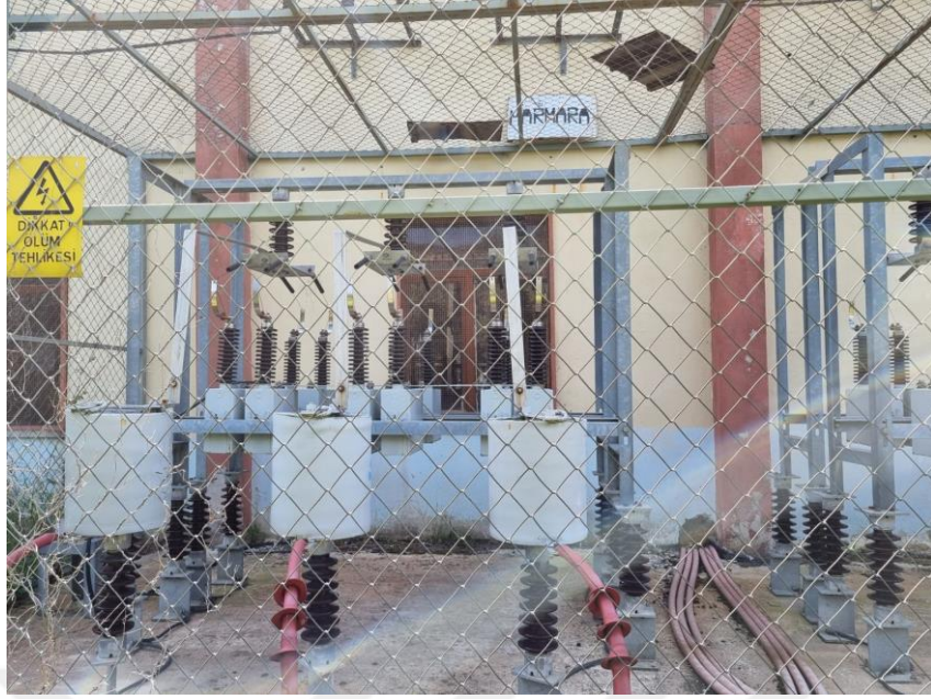
Şekil 2-4: Marmara DM’de kullanılan kapasitörler ve reaktörler
