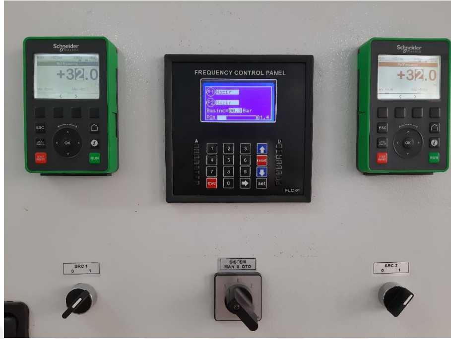
Şekil 4.47. Pompaların debisini ayarlamak için kullanılan frekans konvertörü
