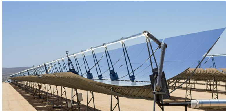
Şekil 2.1. Parabolik oluk tipi yoğunlaştırıcı güneş enerjisi sistemi (Montanes vd., 2017)
