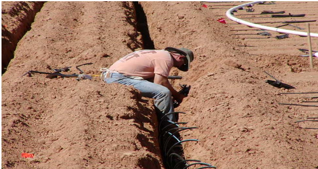
Şekil 2.25. Yeraltı sulama boruları kurulumu.
