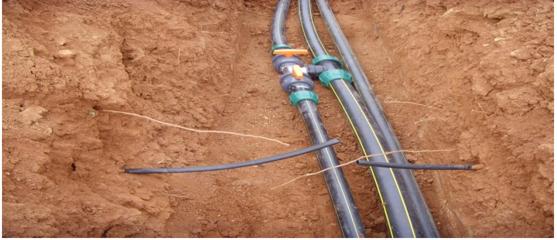
Şekil 2.11. Toprak altı damla sulama boruları kurulumu.
