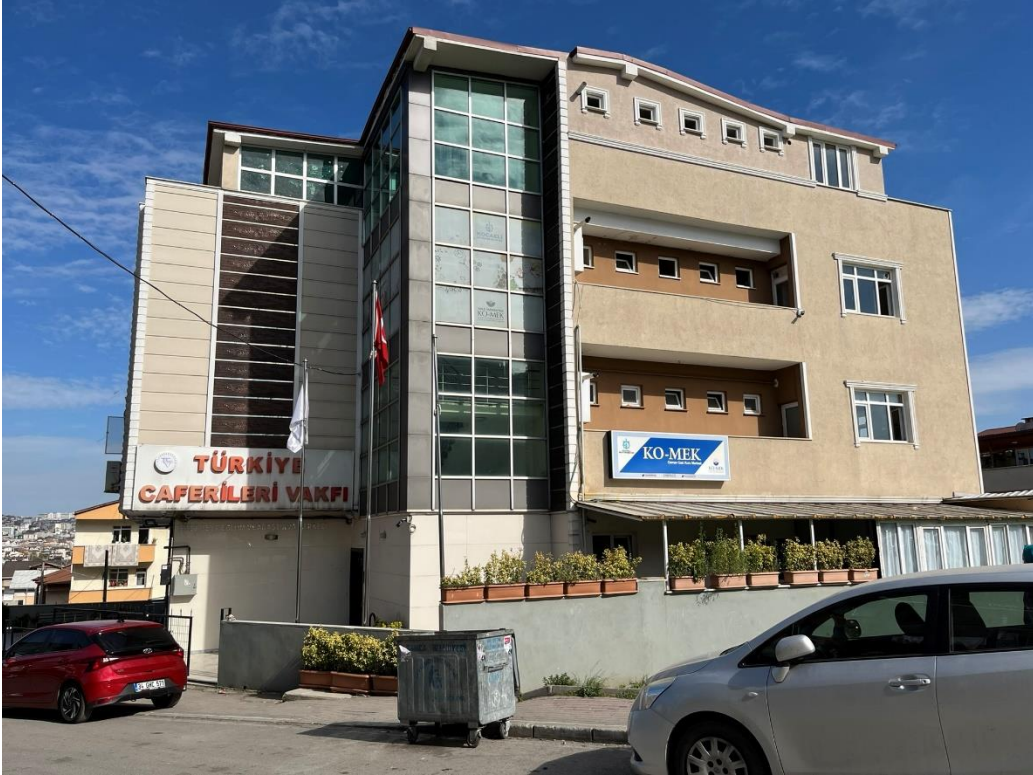
2. Görsel: İzzet Öztaş, TÜRCAY arka cepheden görünümü, (2024).
