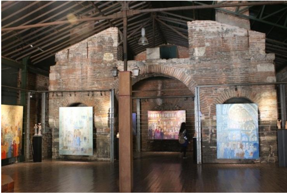
Şekil 4.17 14 numaralı yapıda ocaklar arasındaki kemer bağlantısı.
