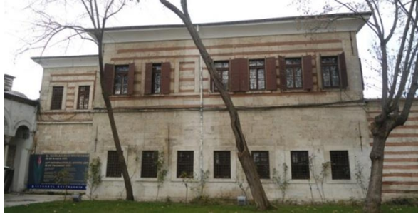
Şekil 3.5 1 numaralı yapı - Darphane Eminliği binası.
