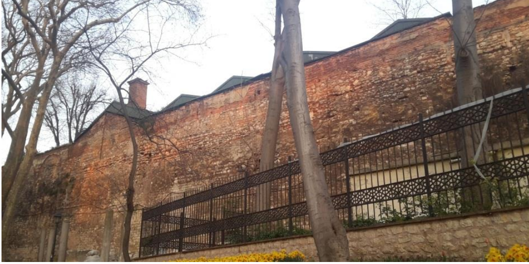
Şekil 4.19 15 numaralı yapının kuzeybatı cephe görünüşü
