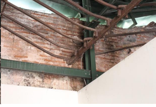
Şekil 4.86 Mertek elemanlarının kirişte birleşimi.
