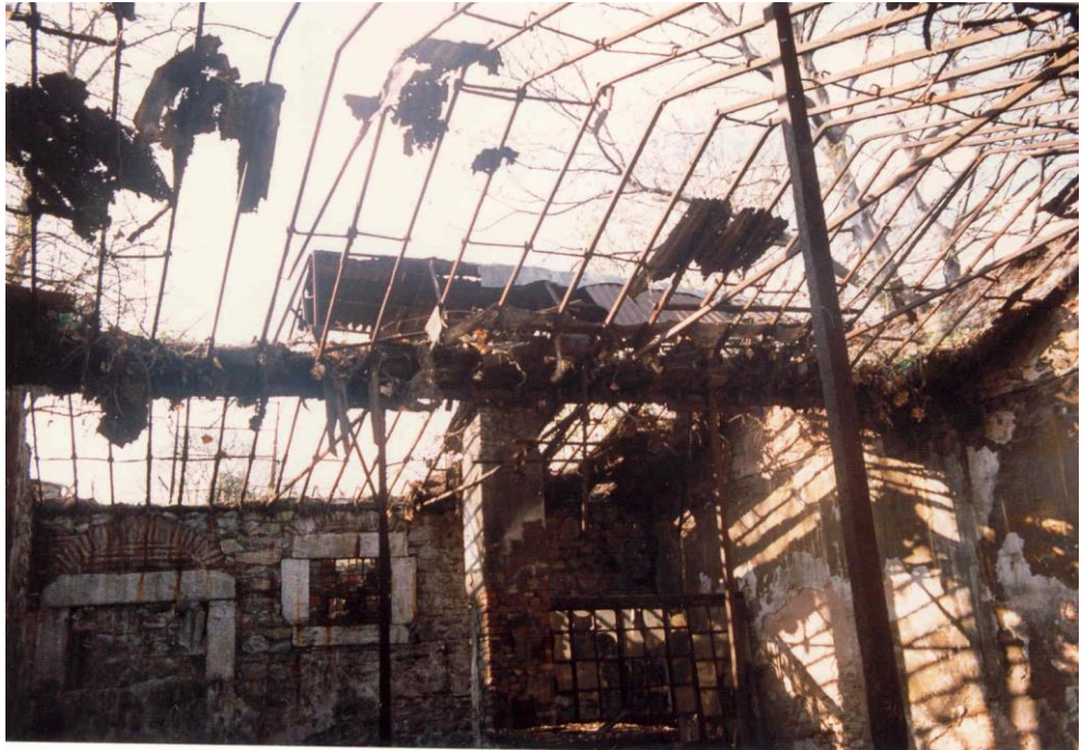
Şekil 4.78 15 numaralı yapının 1996 yılı onarımı öncesi çatı strüktürü [36].
