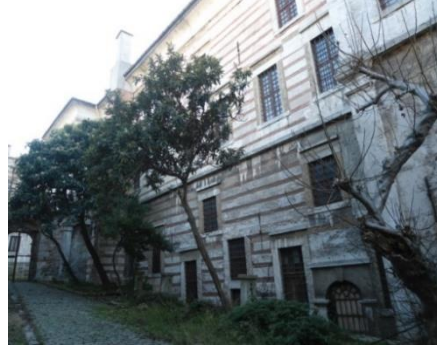
Şekil 3.9 Dökümhane binası kuzeydoğu cephesi.
