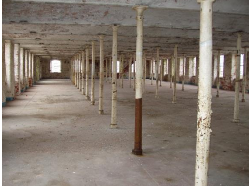
Şekil 2.4 Ditherington Keten Fabrikası iç mekanı görünüşü [16].
