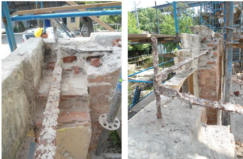
Şekil 2.19 Fehime Sultan Yalısı kagir duvarlarında demir kuşaklama elemanı.
