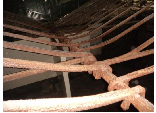
Şekil 4.41 15 numaralı yapı mertek bağlantısı (B detayı).
