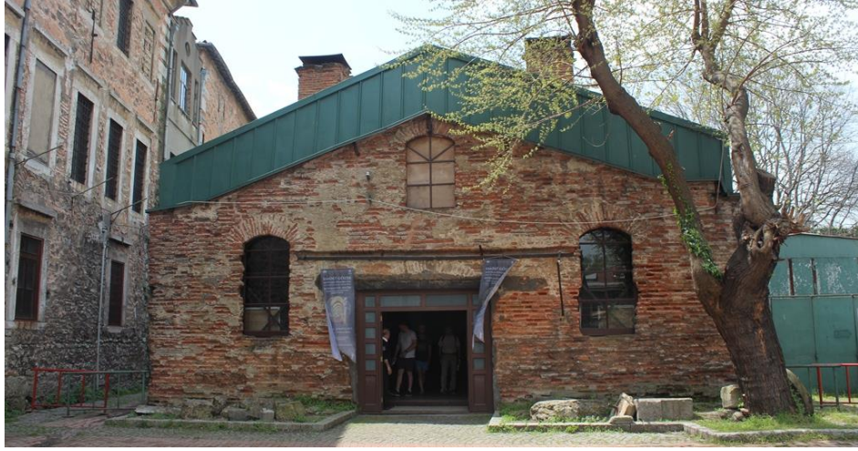
Şekil 4.25 14 numaralı yapının kuzeydoğu cephe görünüşü.
