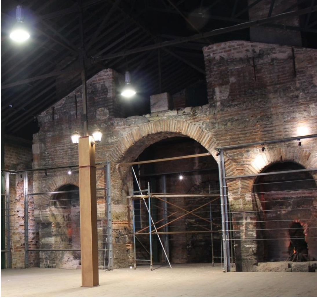
Şekil 4.30 14 numaralı yapı, ocaklar ve üzerindeki makas sistemi.
