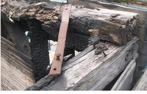
Şekil 2.13 Fehime Sultan Yalısı ahşap duvarlarında birleşim detayı.
