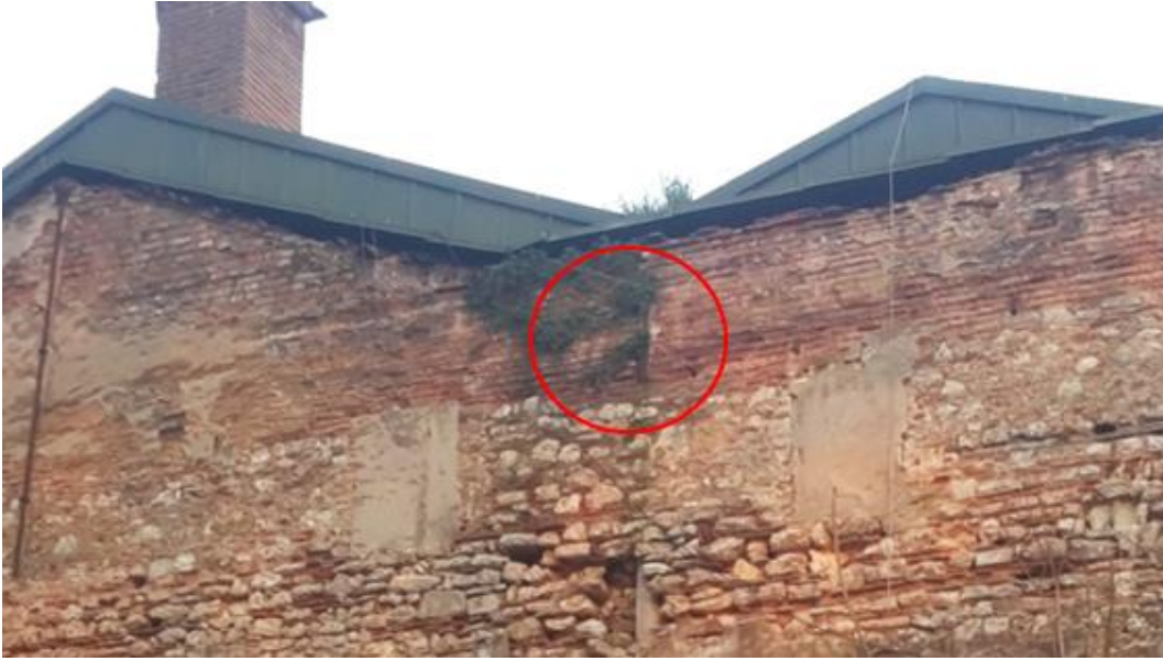
Şekil 4.20 15 numaralı yapı kuzeybatı cephesinde yükseltilmiş aks ile diğer aks arasında görülen kılıçlama elemanı.
