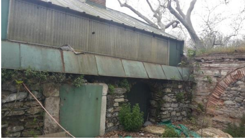
Şekil 4.23 15 numaralı yapının kuzeydoğu cephe görünüşü.
