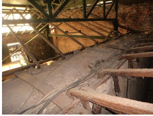
Şekil 4.45 15 numaralı yapı mertek bağlantısı (D detayı).
