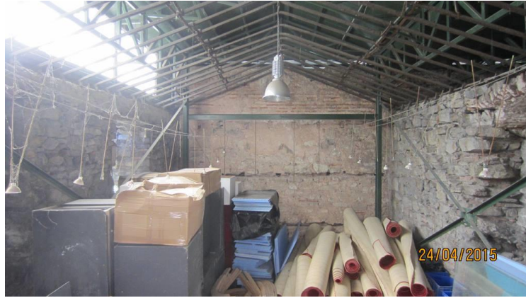
Şekil 4.15 15 numaralı yapı, ZK02 numaralı mekan görünüşü.
