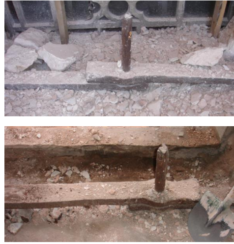
Şekil 2.17 Yavuz Sultan Selim Camii kuşaklama birleşimi.
