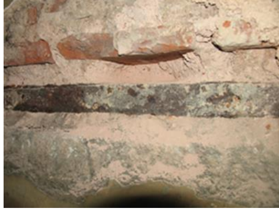
Şekil 2.18 Süleymaniye Camii kubbesinde kubbe pencereleri üzerinden geçen ve kafa tahtası olarak adlandırılan demir kuşaklama.
