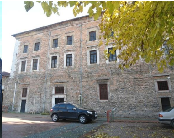
Şekil 3.21 Damga Matbaası kuzeybatı cephesinden bakış.
