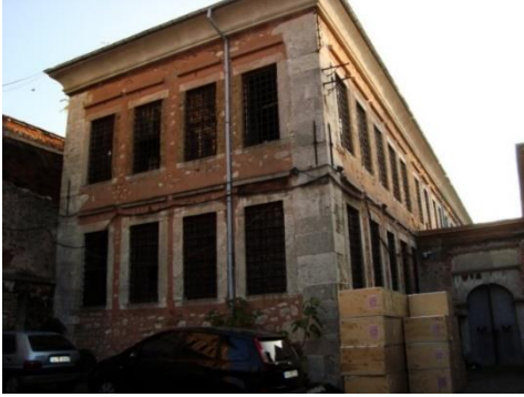
Şekil 3.10 Sıra odalar cephesi.
