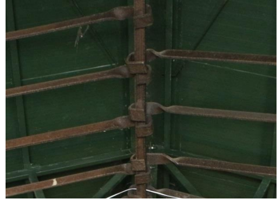
Şekil 4.61 14 numaralı yapı mahya birleşimi (G detayı).
