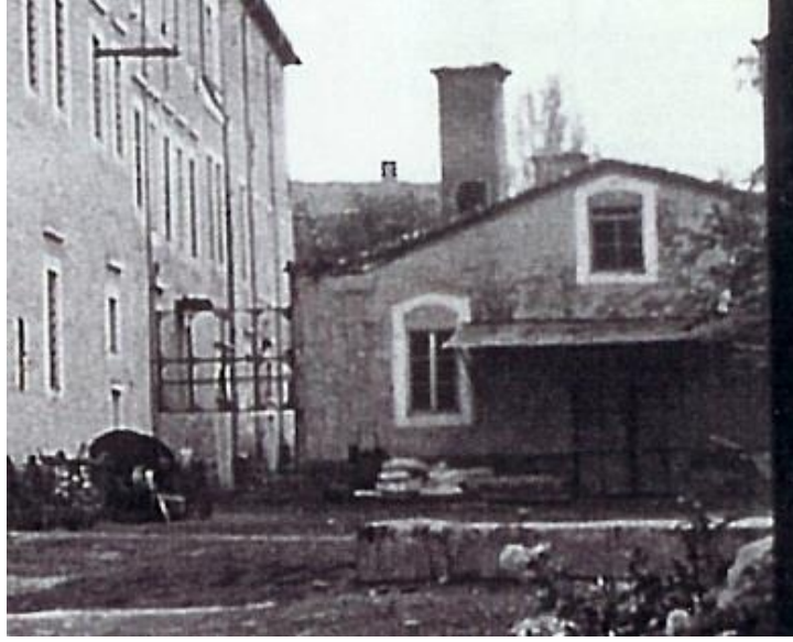
Şekil 3.22 14 numaralı yapının kuzeydoğu cephe görünüşü – 1939 yılı [26].
