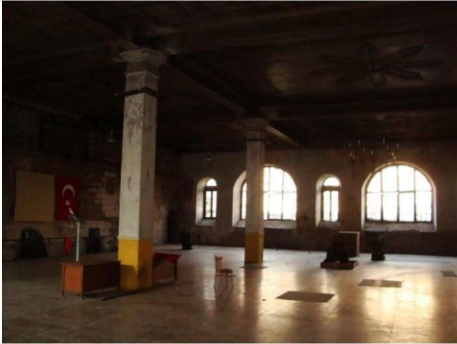
Şekil 3.15 Çarkhane bölümü içinden görünüm.
