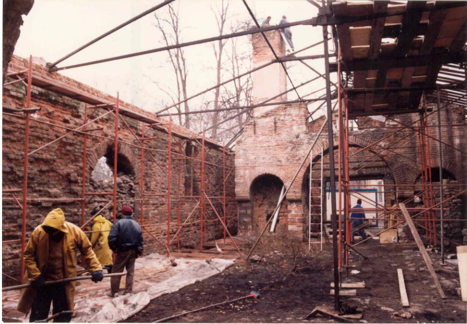
Şekil B. 2 14 numaralı yapının 1996 yılı onarımı sırasında iç mekan durumu[36].
