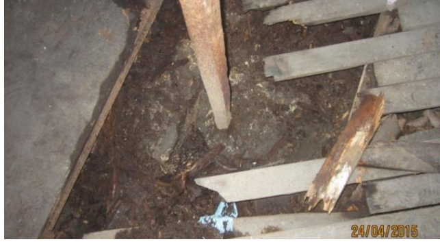
Şekil 4.33 15 numaralı yapıda demir dikmelerin zeminde taş blok içerisinde bağlantısı.
