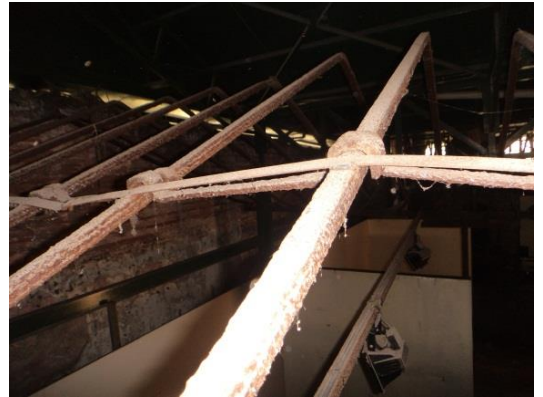
Şekil 4.43 15 numaralı yapı bağlantı elemanı (C detayı).
