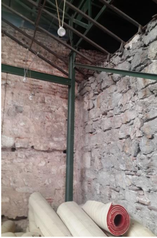
Şekil 4.28 ZK01 ve ZK02 arasında yer alan duvar birleşimi.
