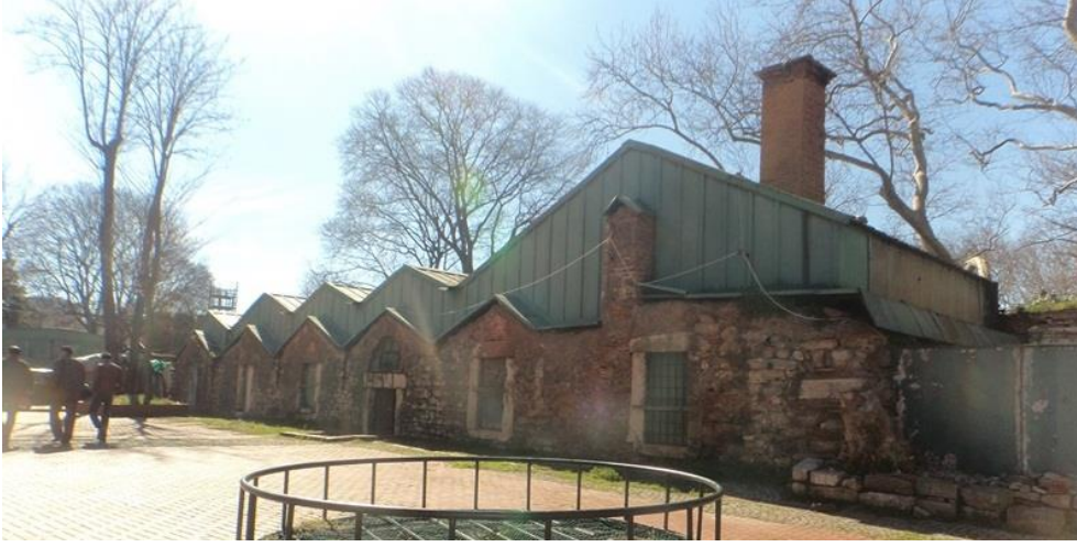
Şekil 3.24 15 numaralı yapı kuzeydoğu cephesi.
