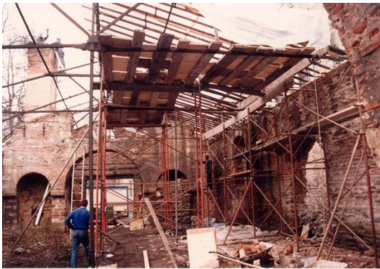
Şekil 4.7 14 numaralı yapının 1996 yılı onarımı [36].
