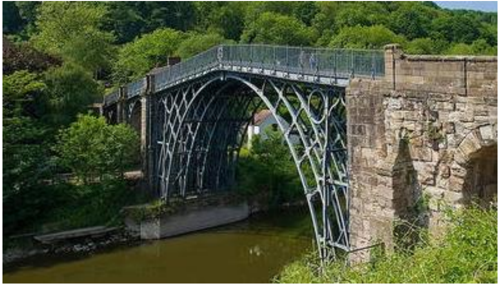
Şekil 2.2 Dövme demirden inşa edilen ilk köprü: Iron Bridge, Coalbrookdale, İngiltere [14].
