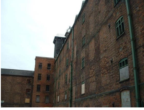
Şekil 2.3 Ditherington Keten Fabrikası cephesi görünüşü [15].
