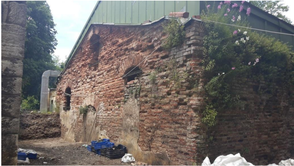
Şekil 4.26 14 numaralı yapının güneybatı cephesi.
