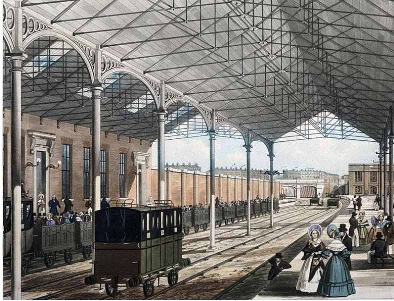
Şekil 2.5 Euston Tren İstasyonu dövme demir kafes çatısını gösteren baskı [18].
