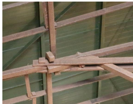
Şekil 4.55 14 numaralı yapı yanlama birleşimi (D detayı).
