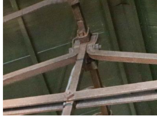
Şekil 4.53 14 numaralı yapı mahya aşığı birleşimi (C detayı).
