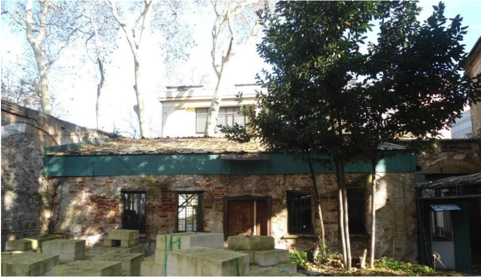
Şekil 3.25 16 numaralı yapı güney batı cephe görünüşü.
