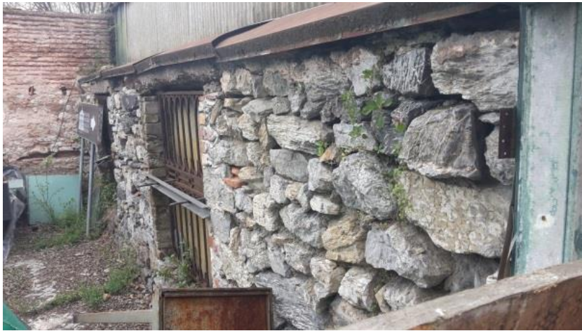
Şekil 4.24 15 numaralı yapının güneybatı cephe görünüşü.
