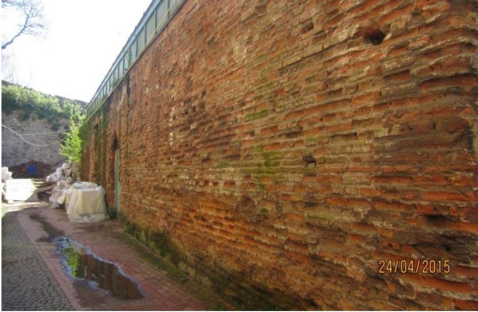
Şekil 4.27 14 numaralı yapının güneydoğu cephesi.
