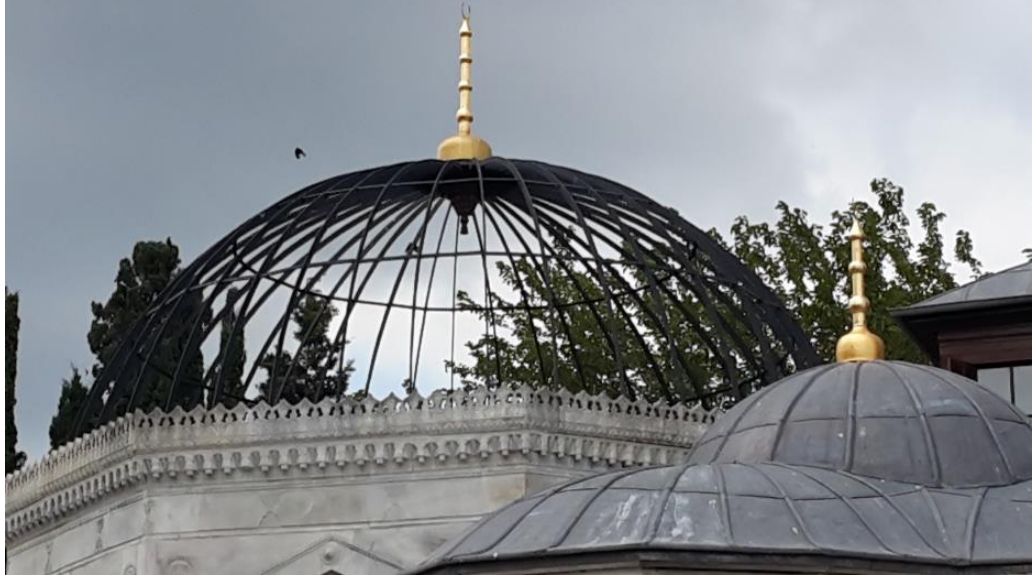
Şekil 2.20 Gülsüm Emetullah Valide Sultan türbesi demir üst örtüsü.
