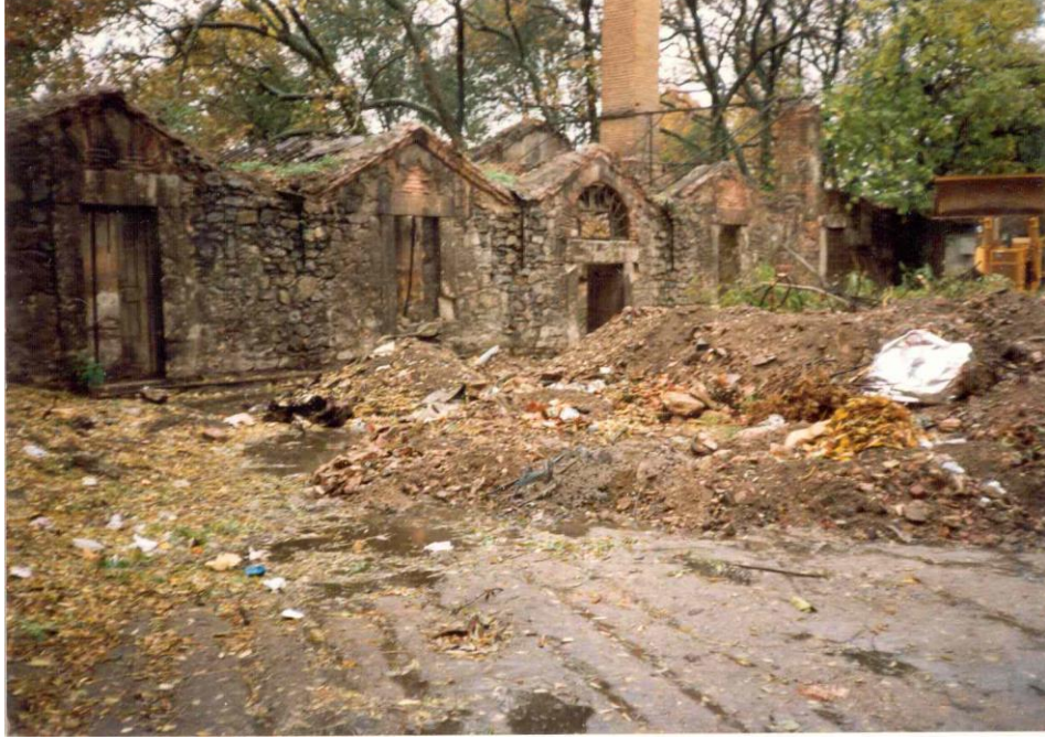
Şekil A. 1 15 numaralı yapının 1996 yılı onarımı öncesi cephe durumu [36].
