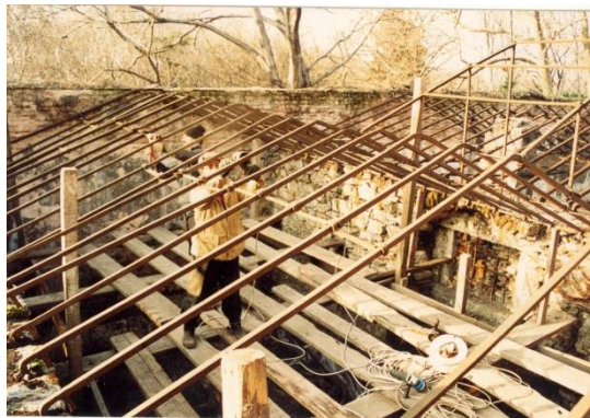
Şekil 4.8 15 numaralı yapının 1996 yılı onarımı [36].
