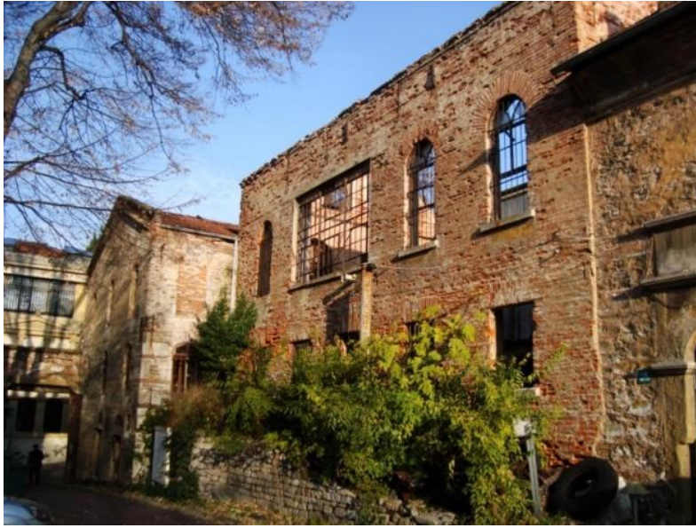
Şekil 3.17 Alt avludan transmisyon ve kazan dairesinin cephe görünümü.
