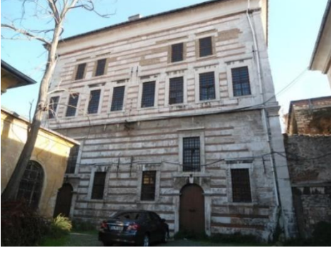
Şekil 3.8 Dökümhane binası kuzeybatı cephesi.
