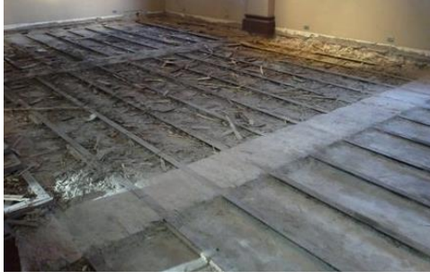
Şekil 2.9 İstanbul Arkeoloji Müzeleri Klasik Bina volta döşemeleri.
