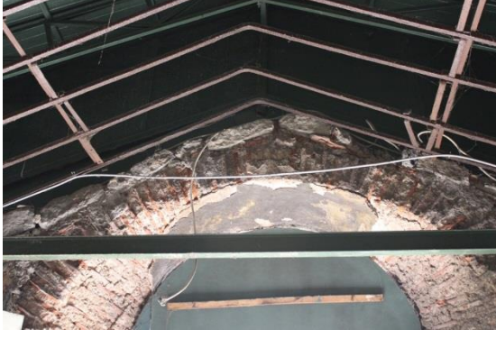
Şekil 4.85 Mertek elemanlarının tepe noktada birleşimi.
