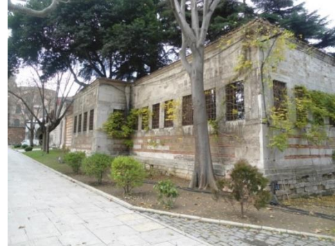
Şekil 3.11 Darphane Köşkü dış duvarları.
