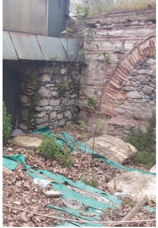
Şekil 4.29 Kuzeydoğu cephesi ile bahçe duvarı birleşimi.
