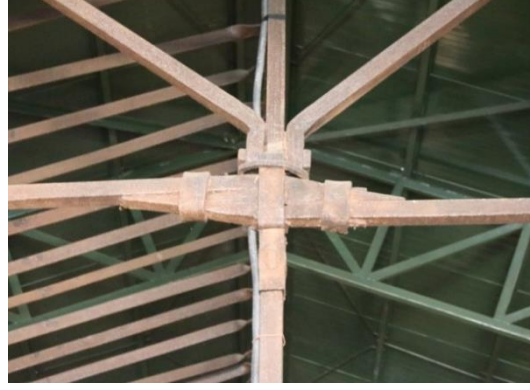
Şekil 4.49 14 numaralı yapı makası bağlantısı (A detayı).
