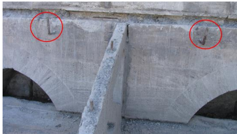
Şekil 2.11 Süleymaniye Camii'inde duvarda demir kancalar.
