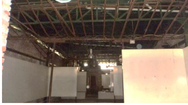
Şekil 4.14 15 numaralı yapı, ZK01 numaralı mekan görünüşü.
