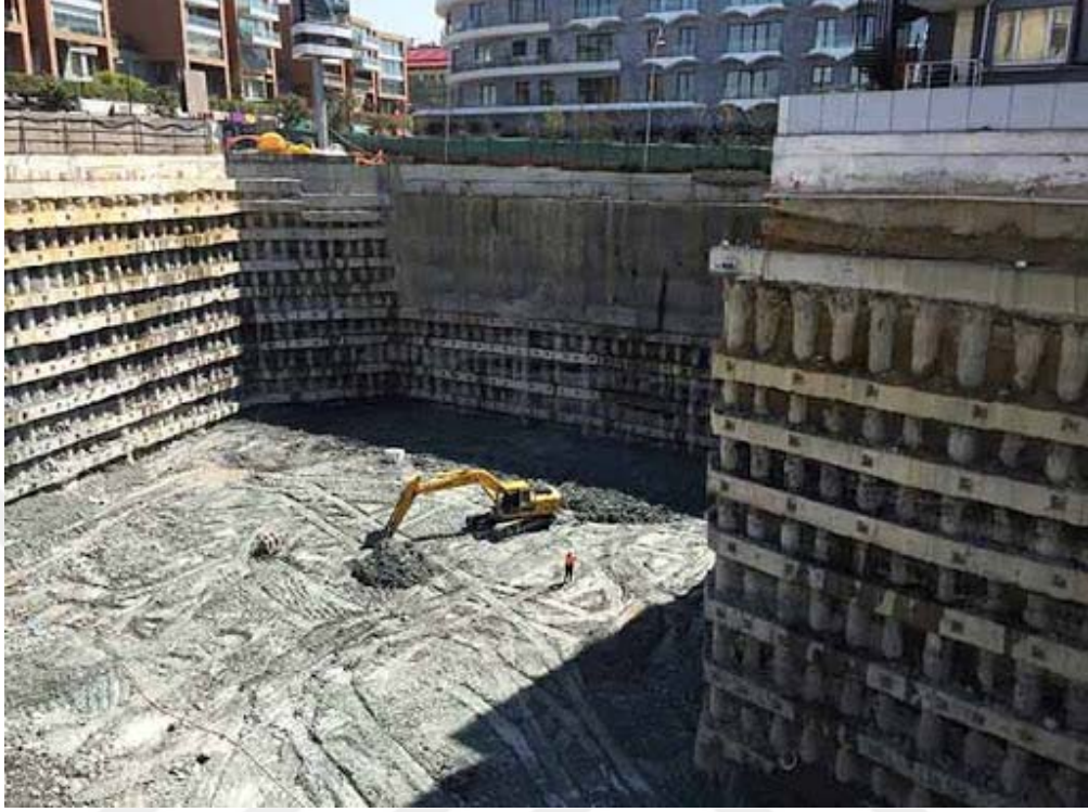
Şekil 2.18. Çok sıra ankrajlı kazıklı perde ile kazı destekleme uygulamaları (TemeltেকMühendislik, 2020)
