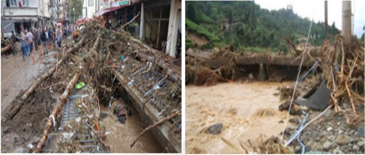
Şekil 2. Taşkın anında taşınan rüsubi malzemenin köprü vb. yapıların kesitlerini tıkaması
