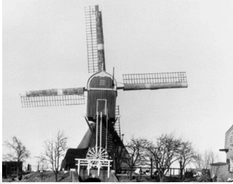
Şekil 1.3 Su pompalamak için kullanılan Hollanda’da yer alan yeldeğirmeni (Hau, 2013)
