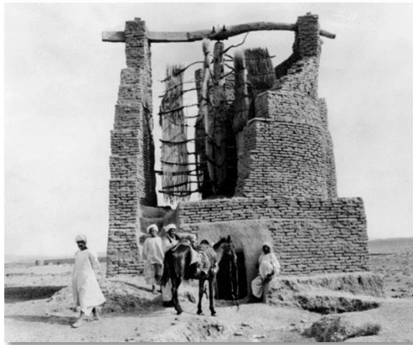
Şekil 1.1 Afganistan'da yer alan düşey dönme eksenine sahip yel değirmeni (Hau, 2013)
