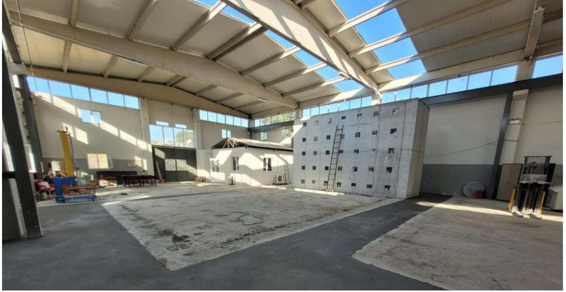
Şekil 3.1 MCBÜ-BAP 2020-115 numaralı projede yapımı gerçekleştirilen güçlü döşeme/reaksiyon duvarı sistemi
