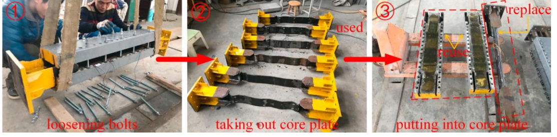
Şekil 2.59 AB-BRB çekirdek plakasının yenisi ile değiştirilme aşamaları
