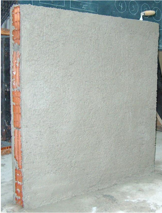
Resim 3.2. Sıvanmış tuğla duvar
