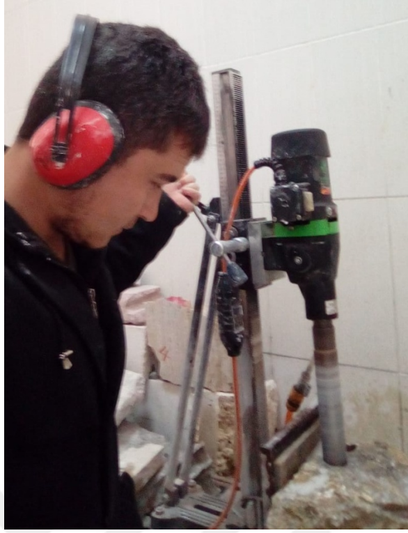
Şekil 4.3. Karot alma makinesi ile karot alma işlemi.
