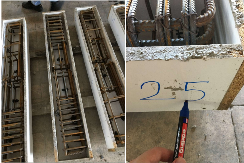
Şekil 4.5. Numunelerin kalıplara yerleştirilmesi
