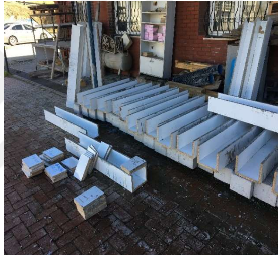
Şekil 4.2. Kalıpların hazırlanması
