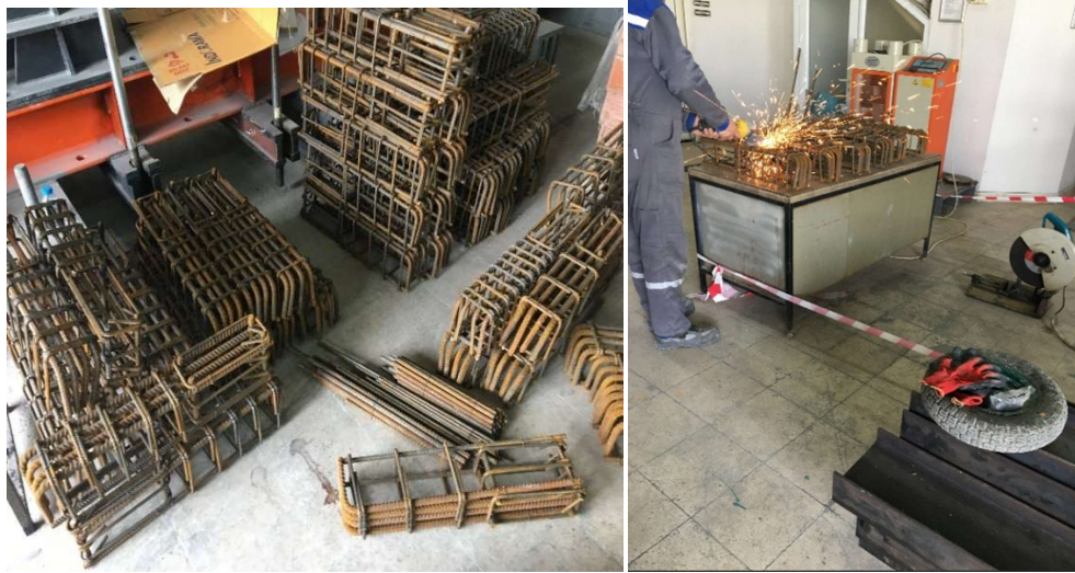
Şekil 4.3. Donatıların hazırlanması
