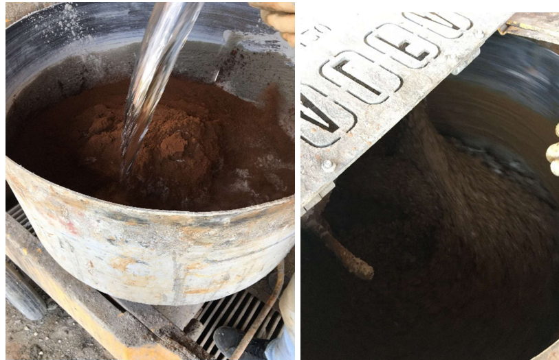
Şekil 4.9. Beton karma işlemi
