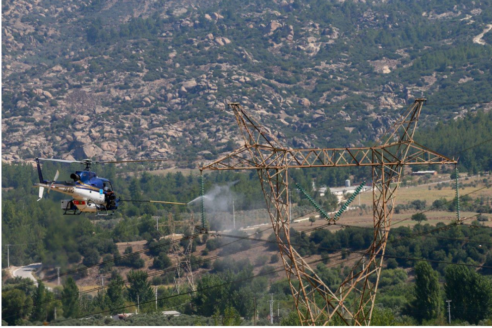
Şekil 2. 8 TEİAŞ Helikopter ile yüksek gerilim hatlarının temizlenmesi (İnt. Kyn. 3).
