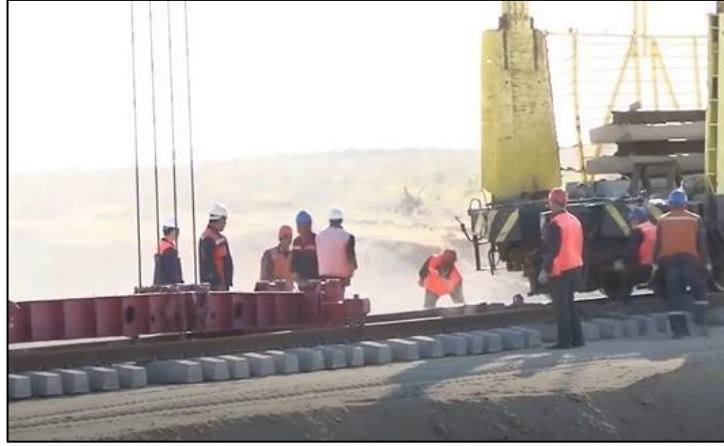
Şekil 4.7. Ray, travers ve bağlantı malzemelerinin yenilenmesi (UTY, 2018).
