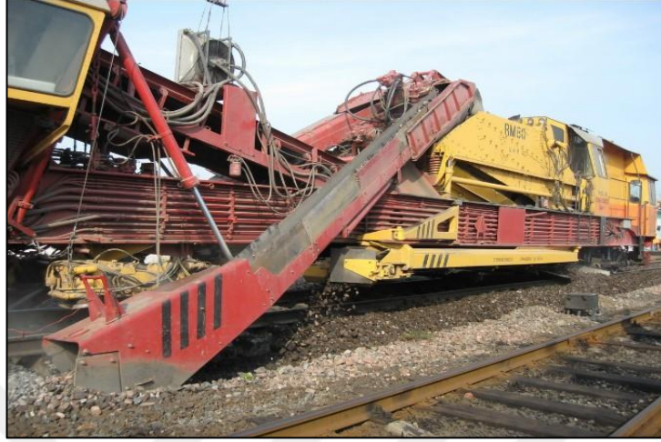
Şekil 4.9. Balast tabakası elemesi (RZD, 2018).
