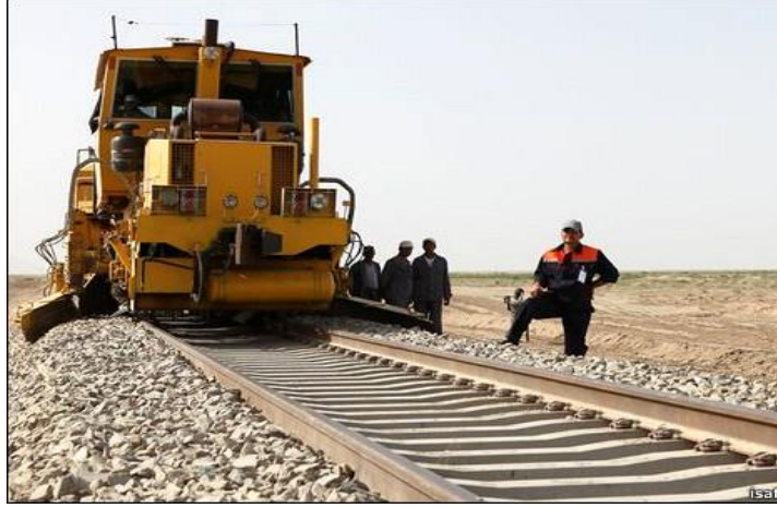
Şekil 4.10. Balast tabakasının enkesiti düzenlenmesi (UTY, 2018).
