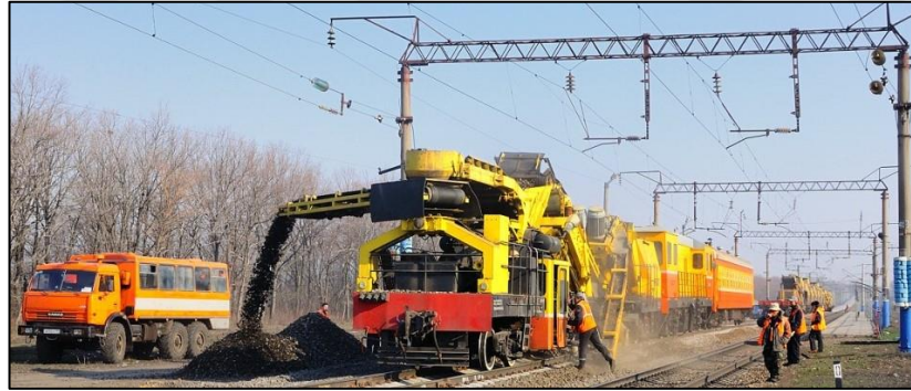
Şekil 4.8. Balast tabakası yenilenmesi (Arteks, 2018).
