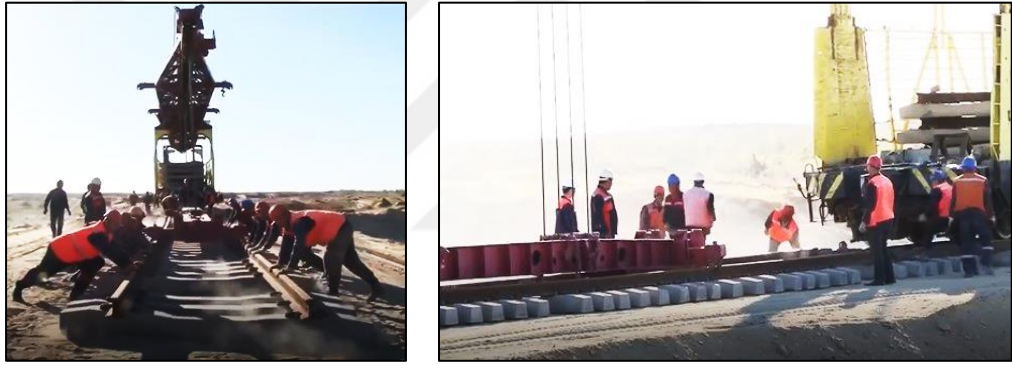
Şekil 5.19. Kızılqum malzemesi üzerine serilen demiryolu hattı (UTY, 2018).
