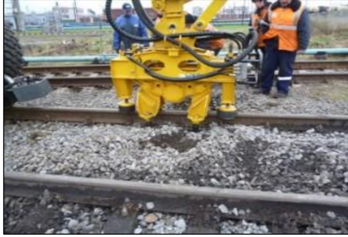
Şekil 4.12. Buraj balast tabakasının sıkıştırılması (RZD, 2018).
