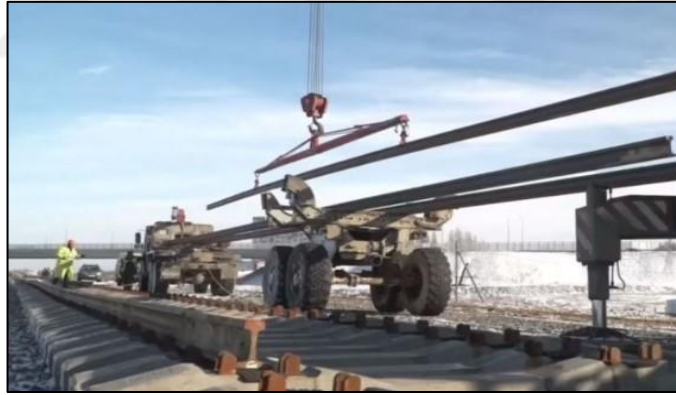
Şekil 4.4. Rayların yenilenmesi (RZD, 2018).
