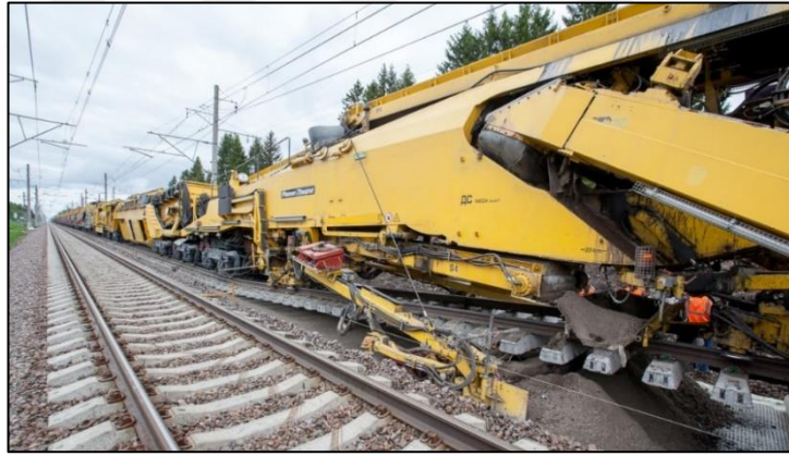
Şekil 4.11. Ray dışında tüm üstyapı bileşenlerinin yenilenmesi (RZD, 2018).
