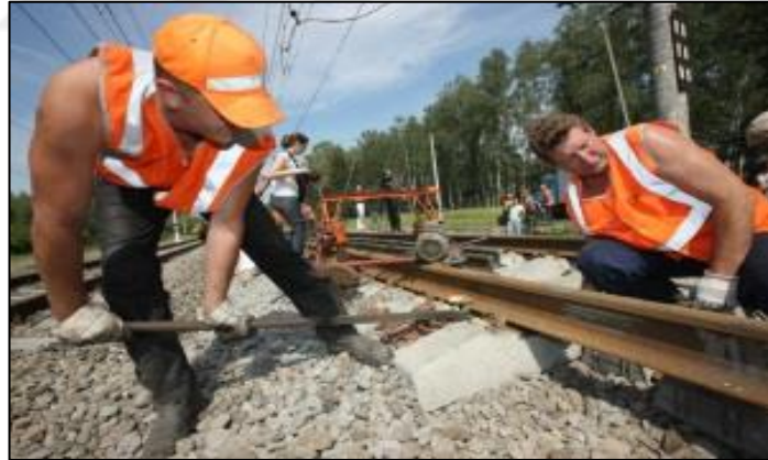
Şekil 4.6. Travers ve bağlantı malzemelerinin yenilenmesi (Transway, 2018).
