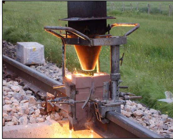
Şekil 6.3. Termitin reaksiyona girdiği pota [54]
