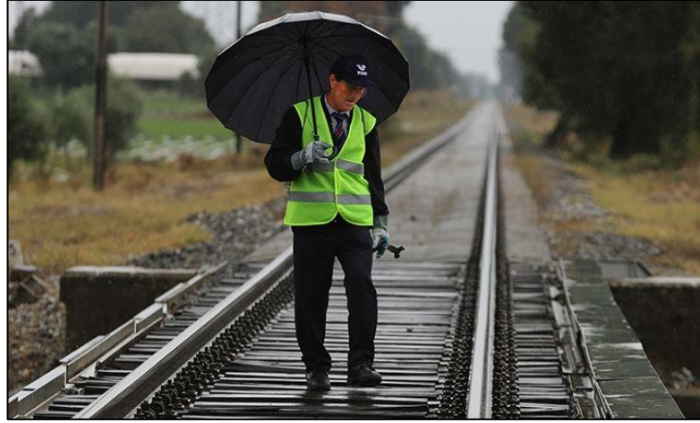
Şekil 7.5. Hat üzerinde görsel inceleme yapan personel [51]
