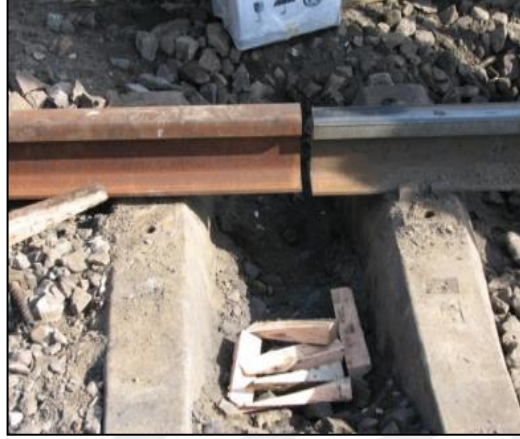
Şekil 6.2. Kaynağa hazır conta [45]
