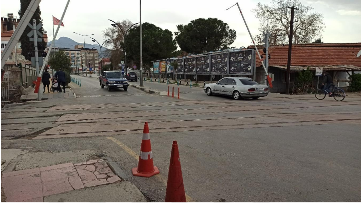
Resim 4. 5. Alaşehir'deki 2 numaralı hemzemin geçit (4.4.2021 tarihinde telefonla çekilmiştir.)
