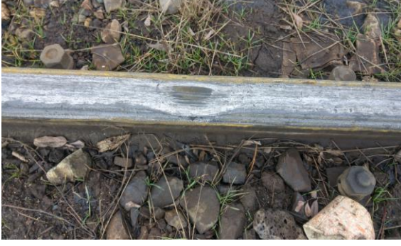
Şekil 2.20. Ray yüzeyinde çökme arızası görüntüleri
