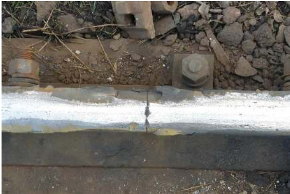
Şekil 2.21. Ray mantarı ile gövde birleşim yerindeki yatay çatlak arızası görüntüleri
