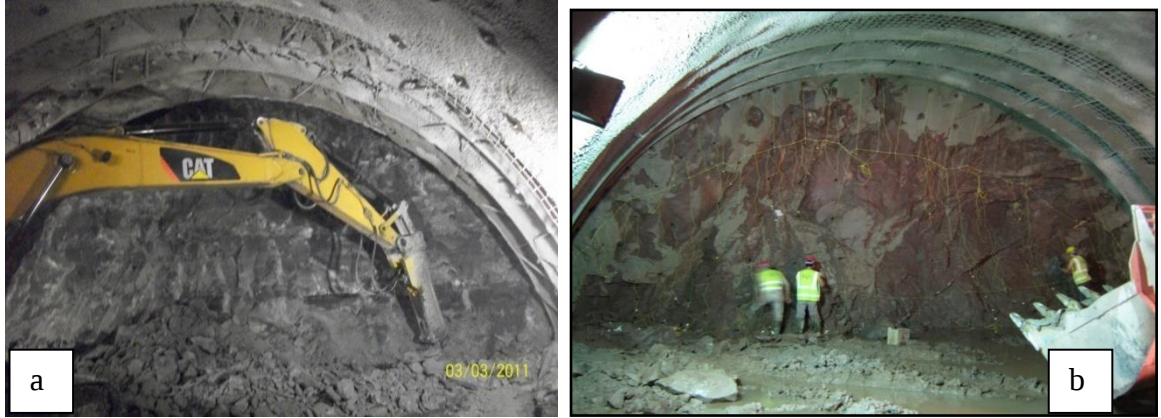
Şekil 2.4. Klasik kazı yöntemleri (a-hidrolik kırıcı, b-delme-patlatma) (Poşluk, 2012).
