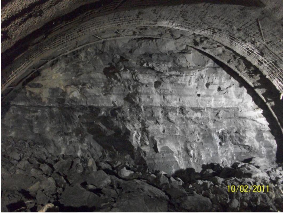
Şekil 7.1. T35’de geçilen Porsuk Formasyonu kıltaşı, silttaşı birimi (Bozüyük).
