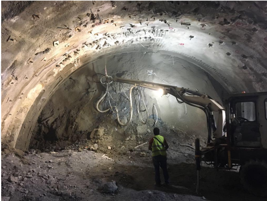
řekil 2.9. Tnel iinde pskrtme beton uygulaması (Ankara-İstanbul Yksek Hızlı Tren Projesi 19 numaralı tnel, Bilecik).
