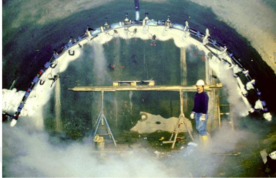
Şekil 2.13. Tünelde zemin dondurma yönteminin uygulanması (Arioğlu, 2018).
