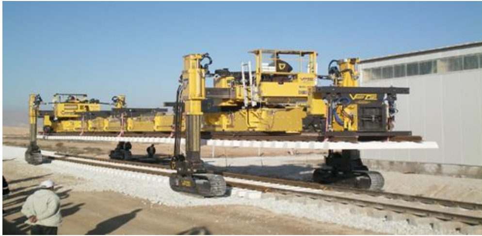
Şekil 4.20. Panelin döşeneceği yere nakli
