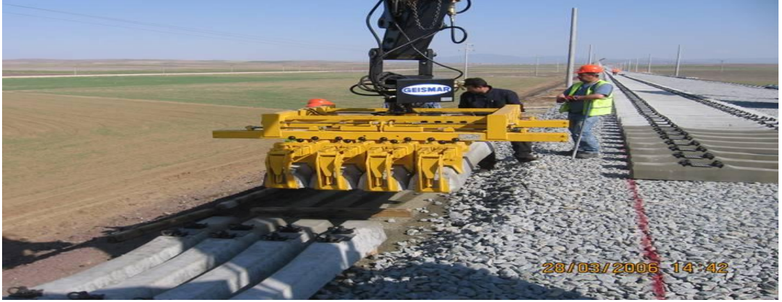
Şekil 4.5. Traverslerin Hattı Serilmesi 1
