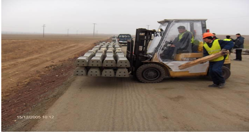
Şekil 4.2. Hatta Taşınan Traversler
