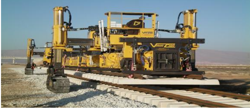
Şekil 4.21. Panelin yerine yerleştirilmesi
