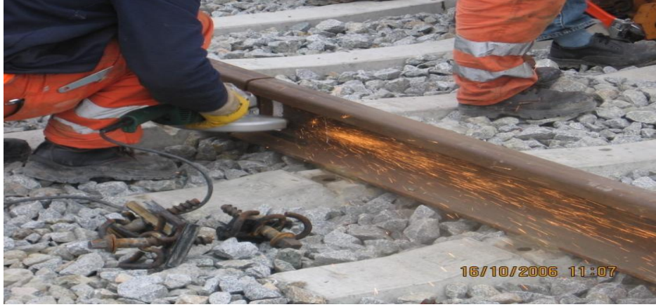
Şekil 4.11. Ray Gövdesinin Taşlanması
