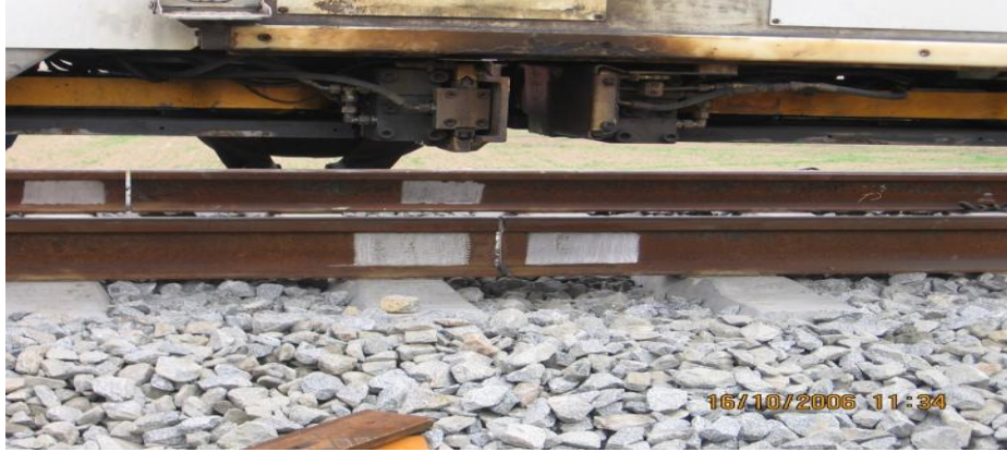
Şekil 4.12. Ray Uçlarının Ayarlanması
