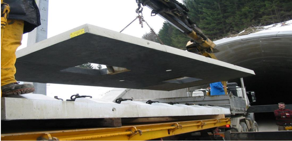
Şekil 5.3. Ray Taşıma Plakalarının Hatta Taşınması
