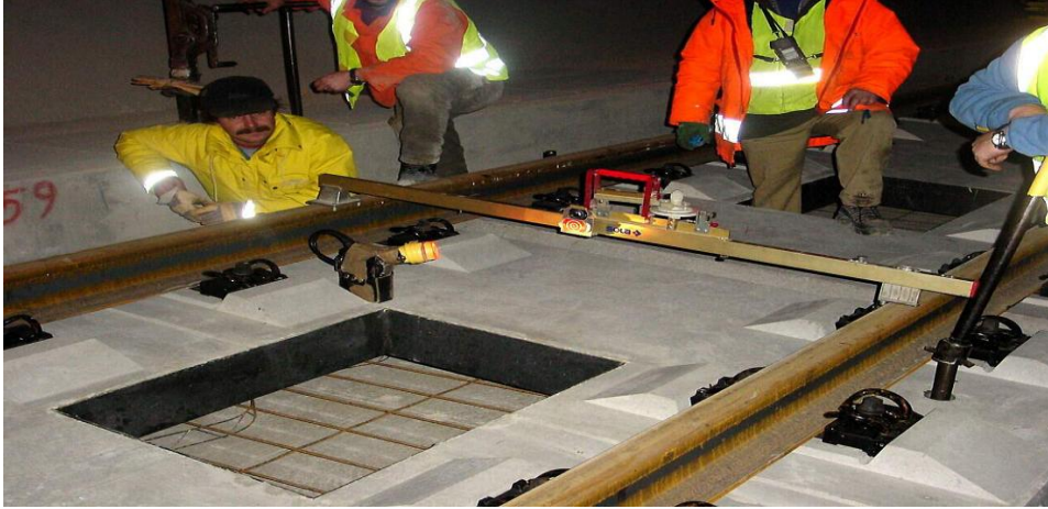
Şekil 5.5. Rayların Ray Taşıma Plakaları Üzerine Montajı
