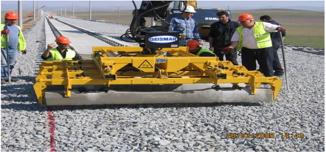
Şekil 4.6. Traverslerin Hattı Serilmesi 2
