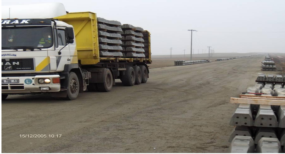
Şekil 4.1. Traverslerin Platforma Taşınması
