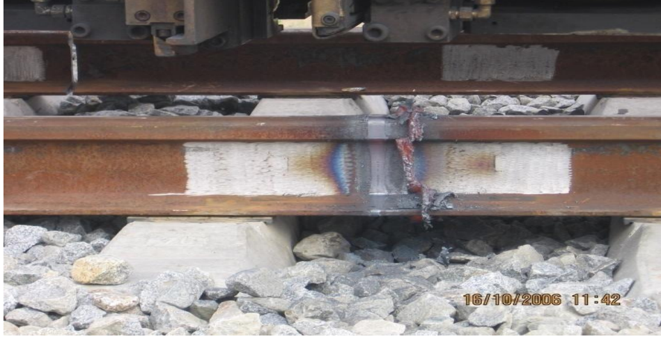
Şekil 4.15. Kaynak Sonrası Rayların İlk Durumu
