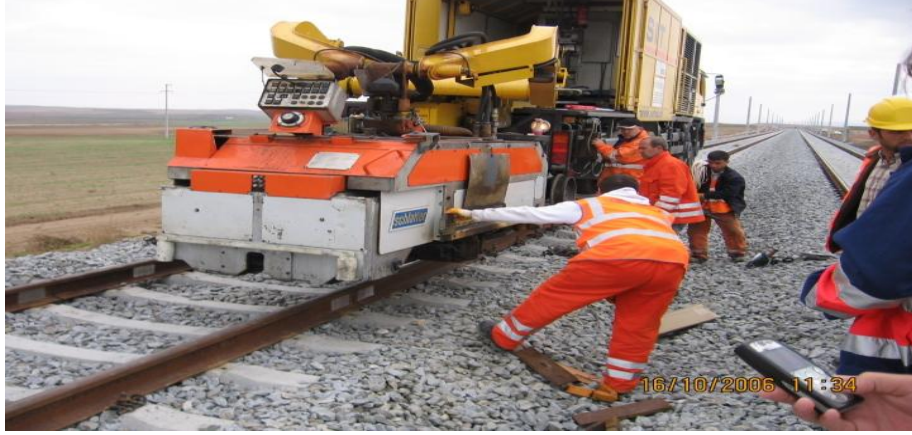
Şekil 4.13. Kaynak Makinesinin Ray Başlarına Göre Ayarlanması
