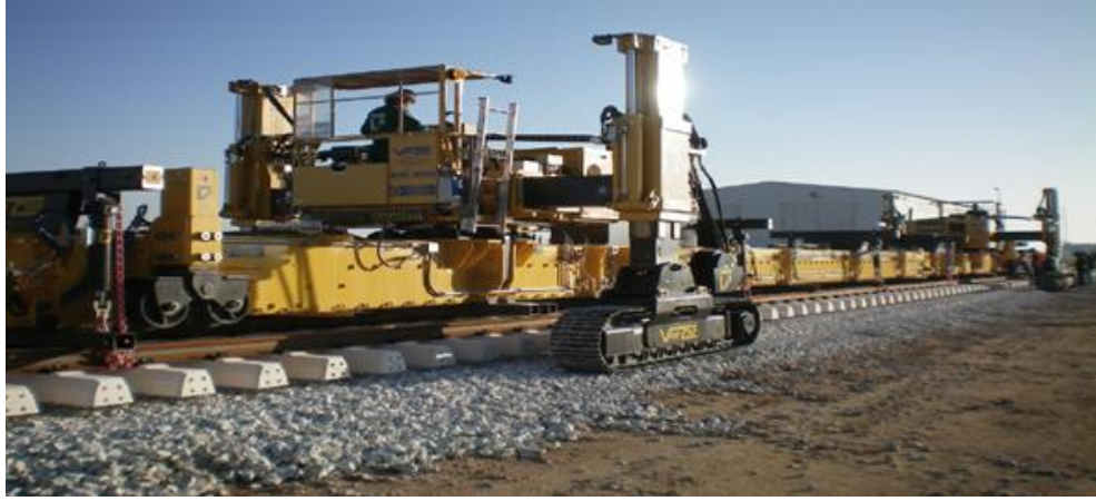
Şekil 4.22. Panelin Toleranslar Dahilinde Güzergaha Göre Ayarlanması
