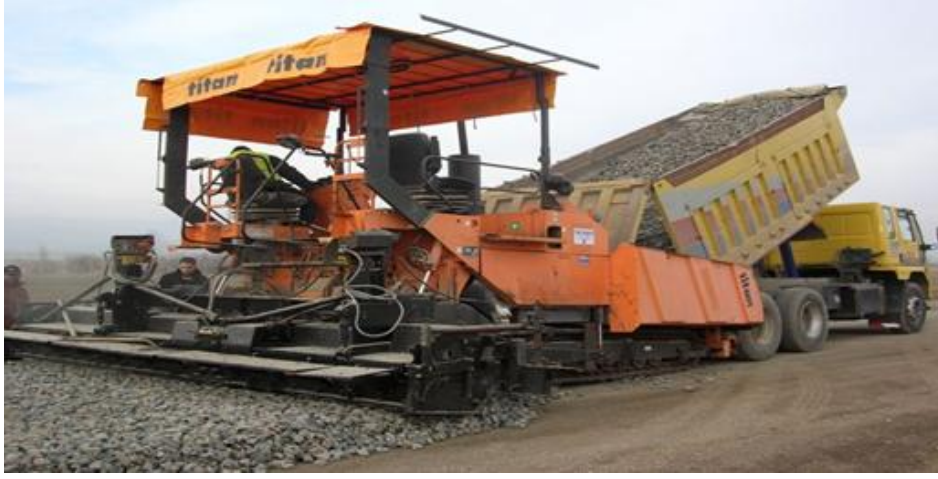
Şekil 4.3. Balast Finisheri İle Balast Serilmesi
