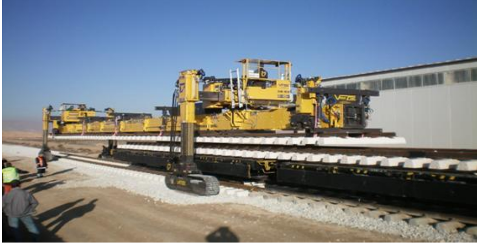
Şekil 4.19. Panelin vagon üzerinden alınması
