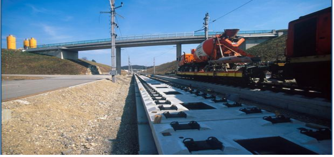
Şekil 5.4. Ray Taşıma Plakalarının Hatta Serilmesi
