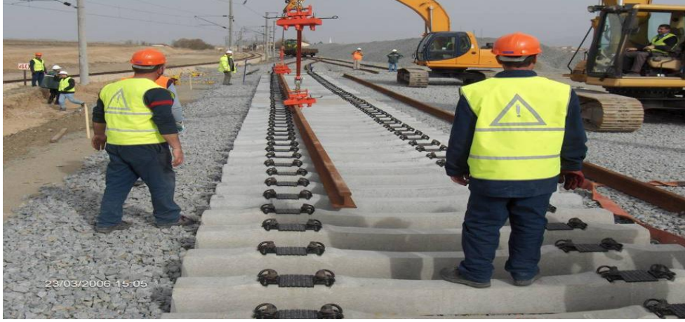
Şekil 4.7. Rayların Traverslerin Üzerine Yerleştirilmesi
