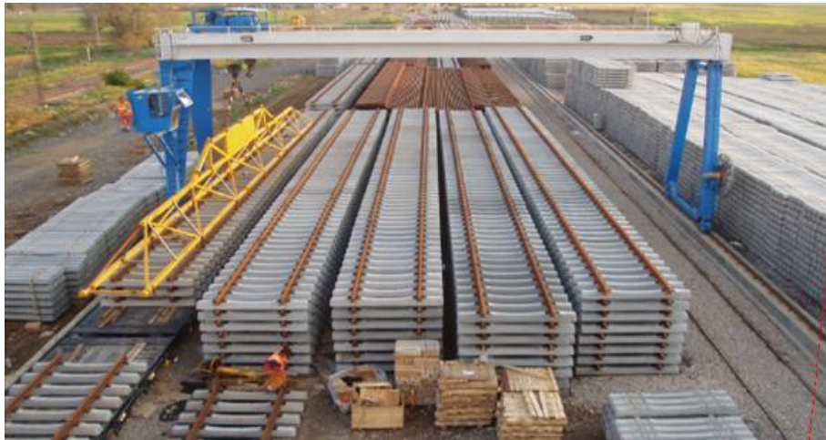
Şekil 4.18. Hat Panellerinin Stoklanması
