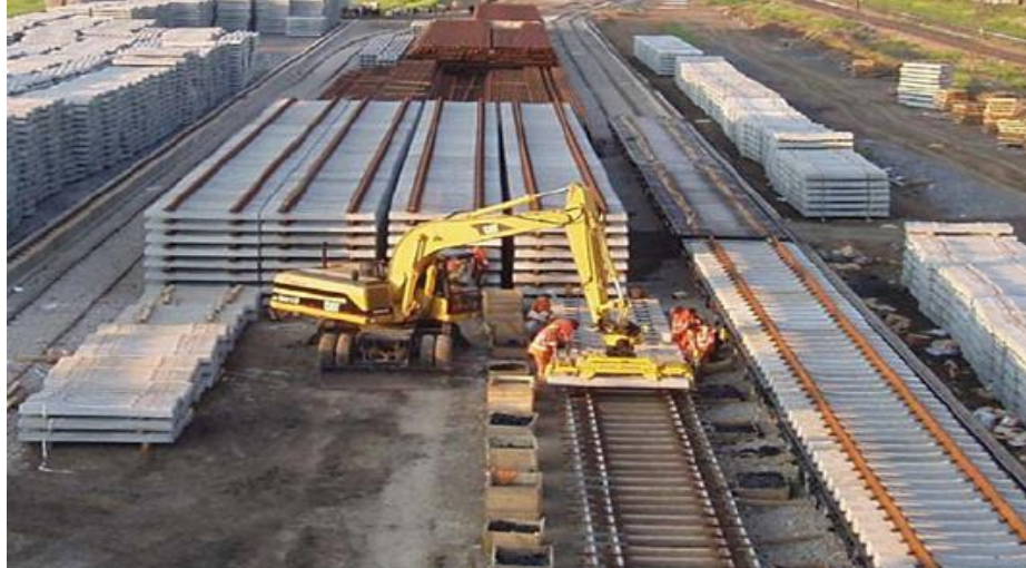
Şekil 4.17. Traverslerin Şablonlar Üzerine Yerleştirilmesi
