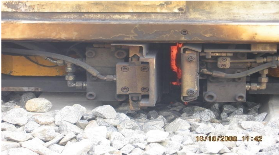
Şekil 4.14. Kaynağın Yapıldığı An
