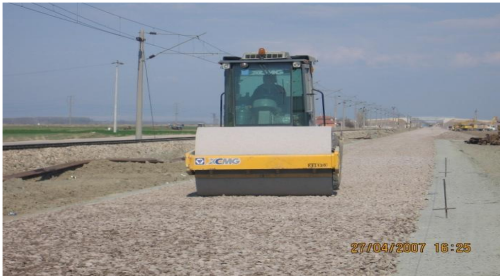
Şekil 4.4. Hatta Serilen Balastın Düz Bandajlı Silindirle Sıkıştırılması
