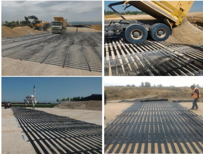
Resim 3.15 Polatlı – Afyon YHT projesi geogrid uygulama görselleri.
