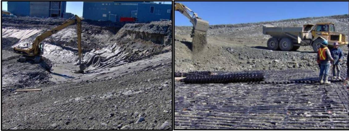
Resim 3.8 Kanada’ da zemin iyileştirme amacıyla geogrid uygulamasının ara dolgu gerekmeden uygulanması örneği (Maccaferri SpA 215).
