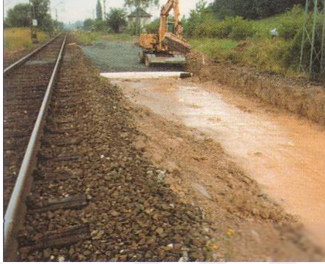
Resim 3.17 Hochstadt ve Probstzella arası demiryolu hattı güçlendirme çalışması (Kwan 2006).
