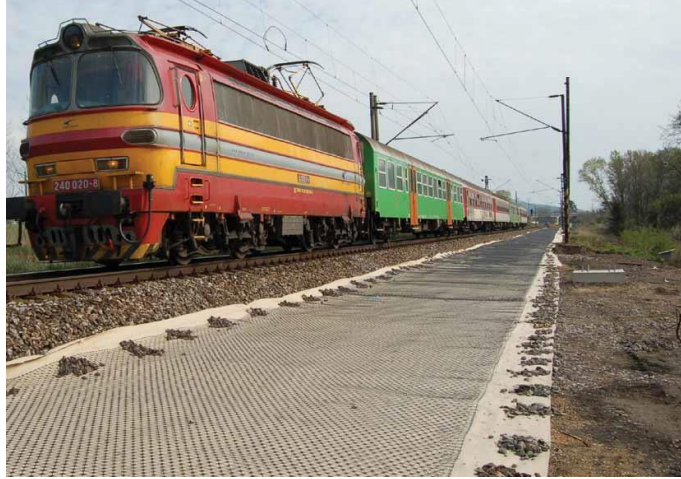
Resim 3.14 Demiryolu altbalast tabakasında geogrid ve geotekstil ürünün birlikte kullanımı (Bratislava – Slovakya) (Tensar 2014).
