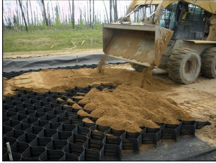
Resim 2.13 Geocell uygulaması (Zanzinger 2019).
