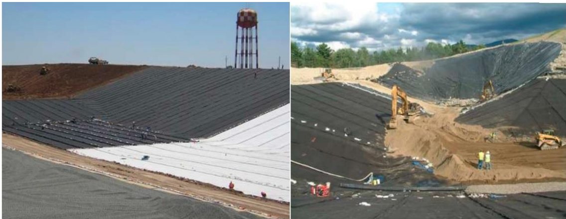
Resim 2.1 Geosentetik ürün ile koruma fonksiyonunun uygulaması (İnt. Kyn. 1).
