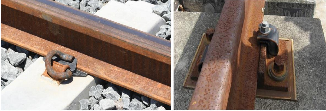
Resim 4.9 Pandrol ve nabla tipi rayı traverse bağlayan bağlantı sistemleri.
