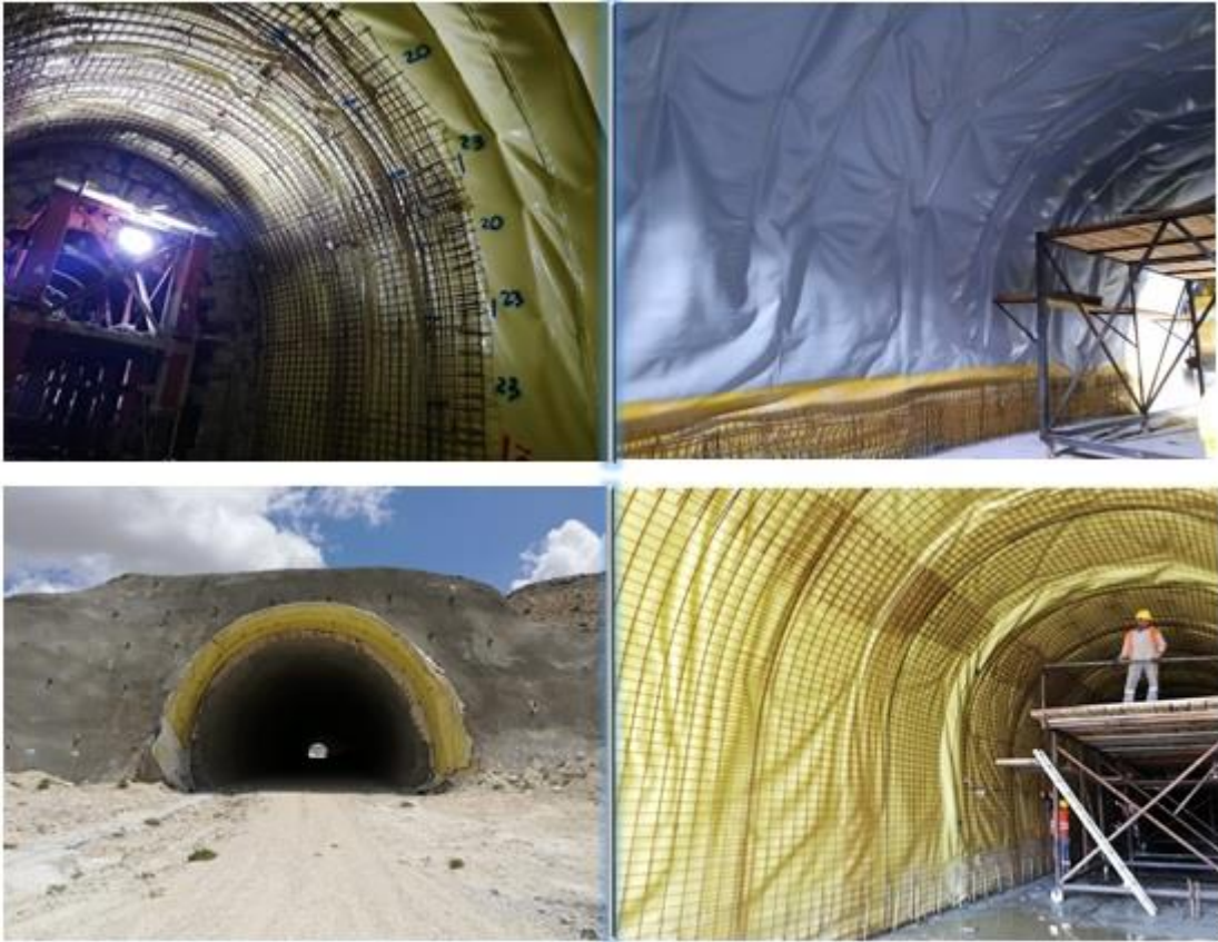
Resim 2.6 Yeraltı tünel yapısında geomembran uygulama örnekleri.
