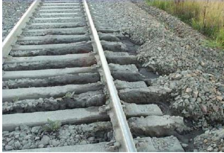
Resim 3.13 Demiryolu balast ile ince malzeme karışımı sonrası taşıma gücünün azalması sorunları ile karşılaşılan bir örnek.
