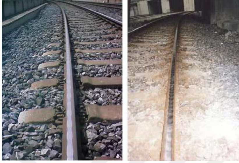
Resim 4.10 Ray aşınması (ondülasyon) örnekleri (Tarhan ve Akpınar 2005).
