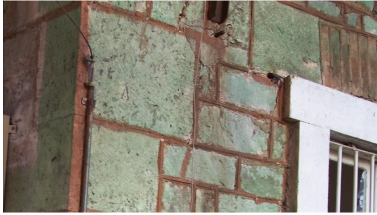
Şekil 4.178 Kesme taş kaplama, Buca yerleşkesi.
