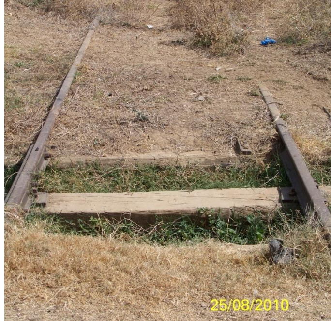
Şekil 5.71 Atıl durumda ve yer yer sökülüş demiryolu hattı, Çivril şube hattı.
