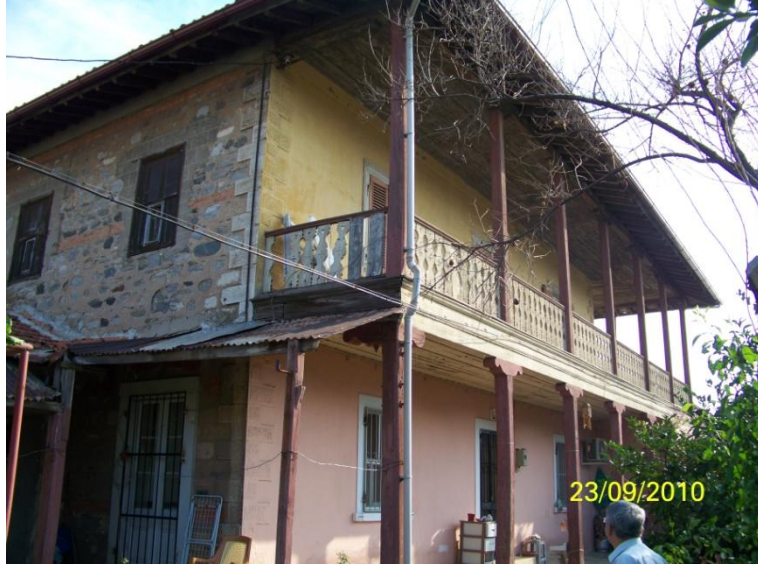
Şekil 4.224 İstasyon şefi lojmanı dış görünüşü, Nazilli yerleşkesi, 2010.
