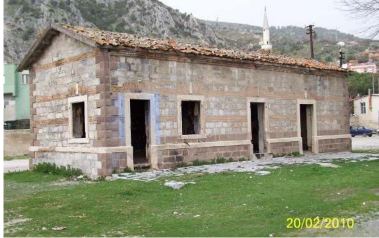
Şekil 4.126 Yolcu bekleme/idare yapısı, Kemer yerleşkesi, 2010.
