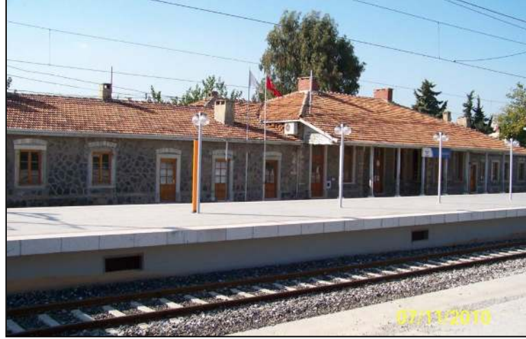
Şekil 4.161 Yolcu bekleme/idare yapısı, Gaziemir Yerleşkesi, 2010.
