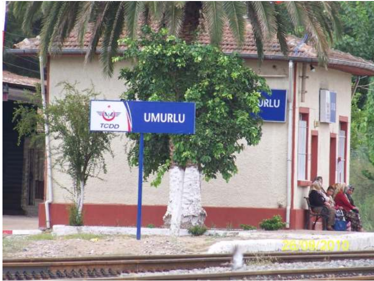
Şekil 4.58 Yeni yolcu bekleme/ idare yapısı, Umurlu yerleşkesi, 2010.
