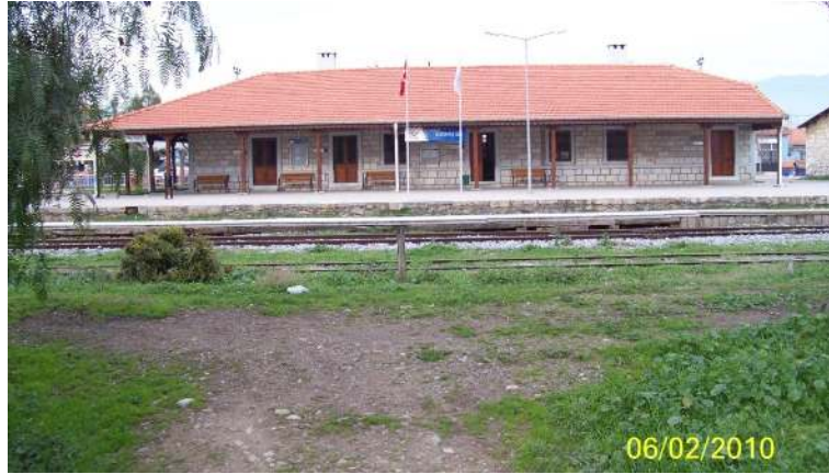
Şekil 4.119 Yolcu bekleme/idare yapısı, Ödemiş yerleşkesi, 2010.
