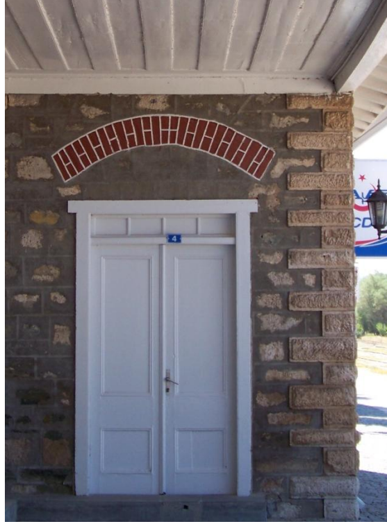
Şekil 4.180 Kesme taş köşe plaster, Dinar yerleşkesi.
