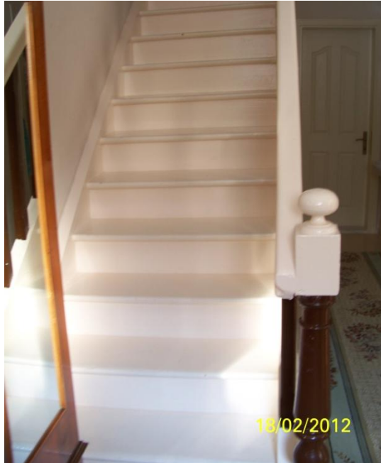
Şekil 4.219 91 no'lu işçi lojmanı, ahşap merdiven detayı, Alsancak, 2012.
