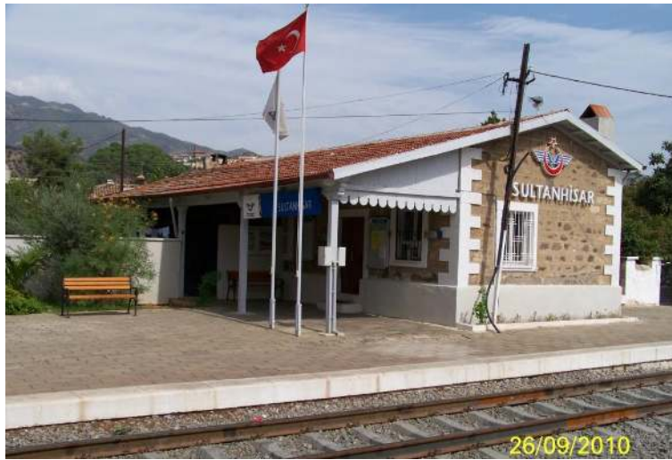
Şekil 4.66 Yolcu bekleme/idare yapısı, Sultanhisar yerleşkesi, 2010.
