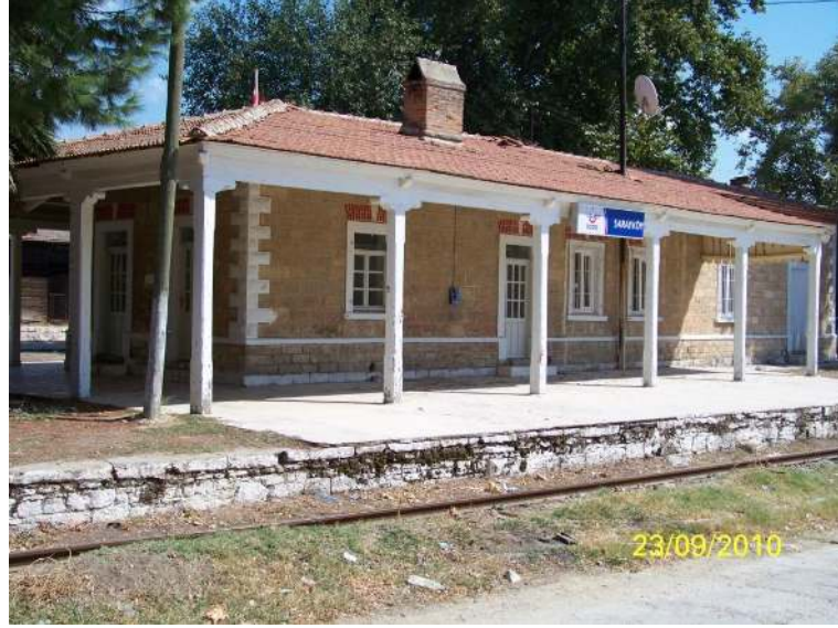
Şekil 4.153 Yolcu bekleme/idare yapısı, Sarayköy yerleşkesi, 2010.
