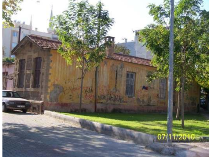
Şekil 5.77 İdari yapı, Seydiköy yerleşkesi, 2010.
