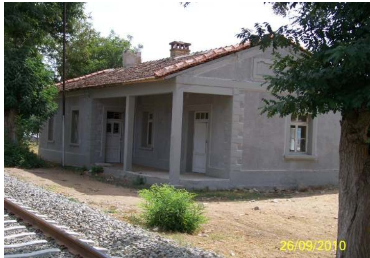
Şekil 4.61 Yolcu bekleme/idare yapısı, Beyköy yerleşkesi, 2010.
