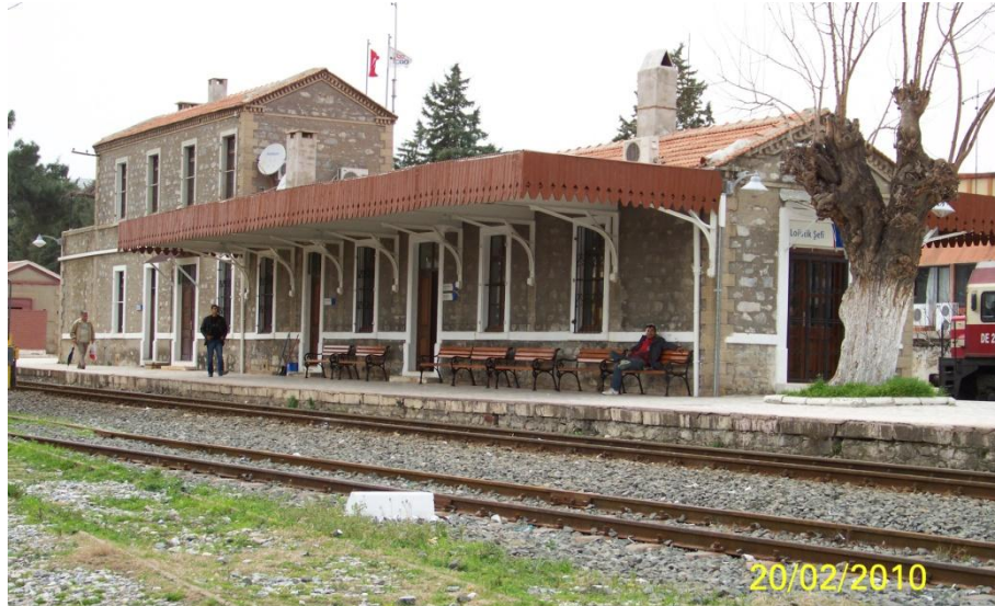
Şekil 4.43 Yolcu bekleme/idare/ikamet yapısı, Reşadiye (Ortaklar) yerleşkesi, 2010.
