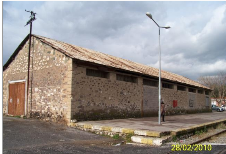
Şekil 4.200 Kapalı depolama yapısı, Torbalı Yerleşkesi, 2010.
