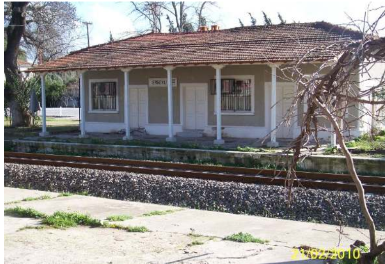
Şekil 4.48 Yolcu bekleme/idare yapısı, Erbeyli yerleşkesi, 2010.
