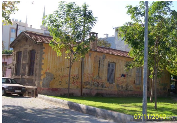
Şekil 4.148 Yolcu bekleme/idare yapısı, Seydiköy yerleşkesi, 2010.
