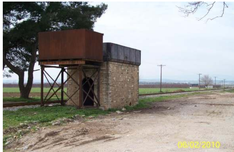
Şekil 4.27 Kuşcuburun yerleşkesinin ayakta kalabilen tek yapısı olan su deposu, 2010.
