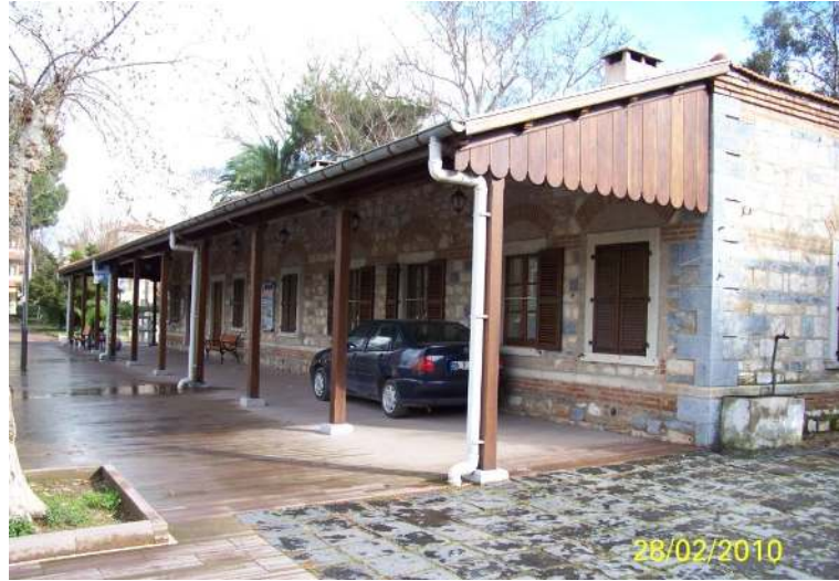
Şekil 4.121 Yolcu bekleme/idare yapısı, Tire yerleşkesi, , 2010.
