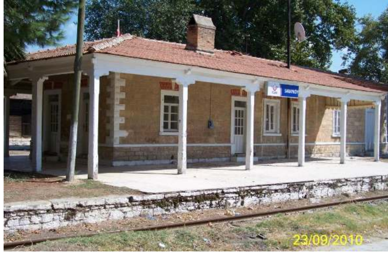
Şekil 4.81 Yolcu bekleme/idare yapısı, Sarayköy yerleşkesi, 2010.
