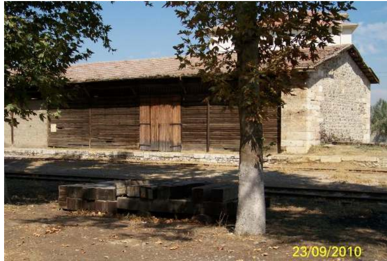
Şekil 4.154 Ürün depolama yapısı, Sarayköy yerleşkesi, 2010.
