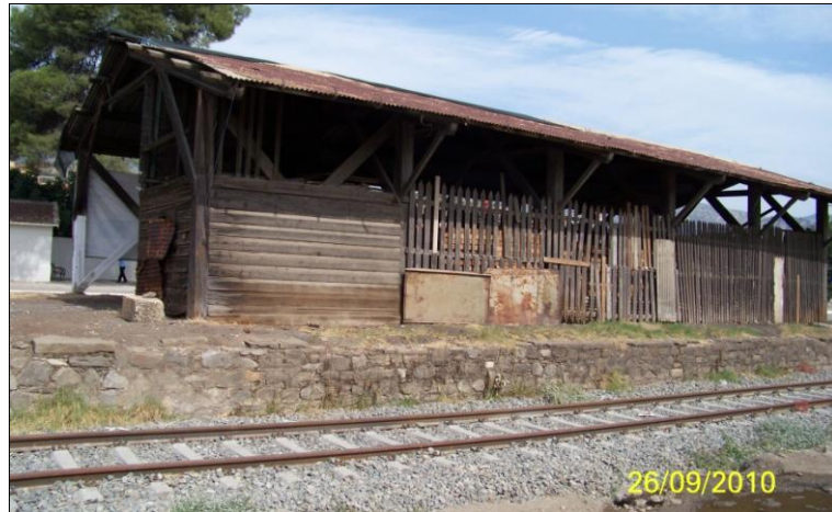
Şekil 4.198 Yarı açık depolama, Sultanhisar Yerleşkesi, 2010.
