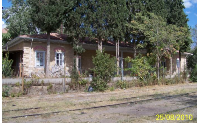
Şekil 4.139 Edaş’a kiralanın yolcu bekleme/idare yapısı, Çivril yerleşkesi, 2010.
