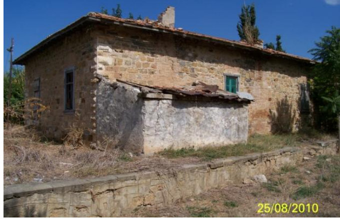
Şekil 4.135 Yolcu bekleme/idare yapısı, Sundurlu yerleşkesi, 2010.
