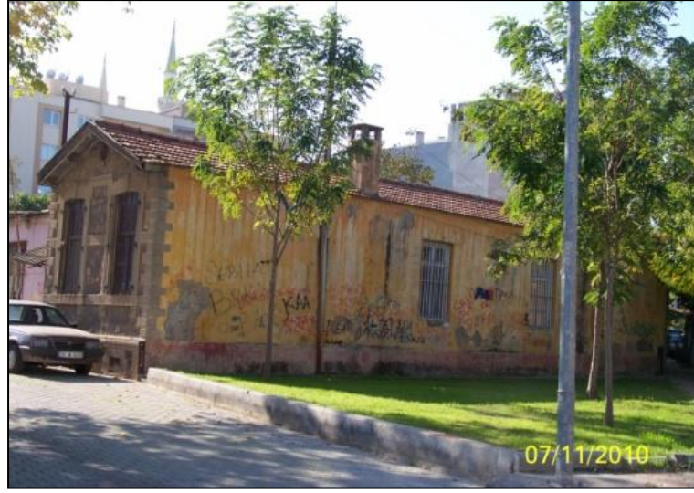
Şekil 4.159 Yolcu bekleme/idare yapısı, Seydiköy Yerleşkesi, 2010.
