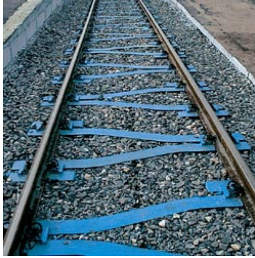
Şekil 3.14: Y tipi çelik travers [17].
