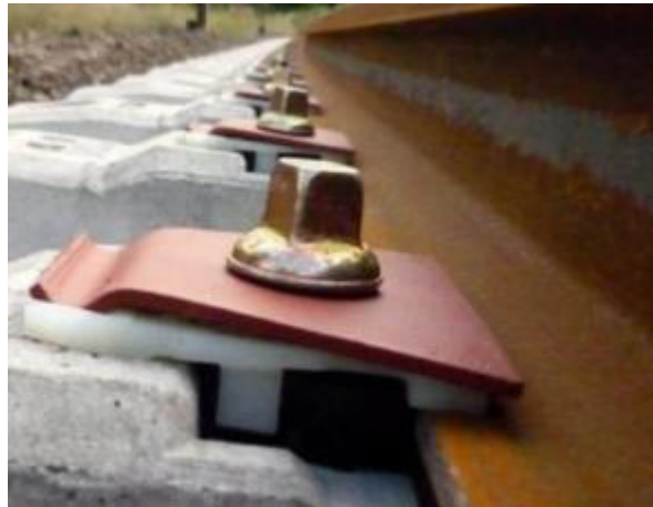
Şekil 3.8: Nabla bağlantı elemanı (cıvatalı elastik bağlantı elemanı) [14].
