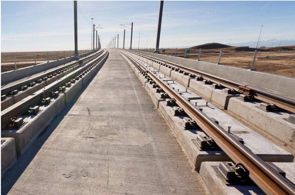
Şekil 3.20: Plinth betonlu üstyapı uygulaması [22].
