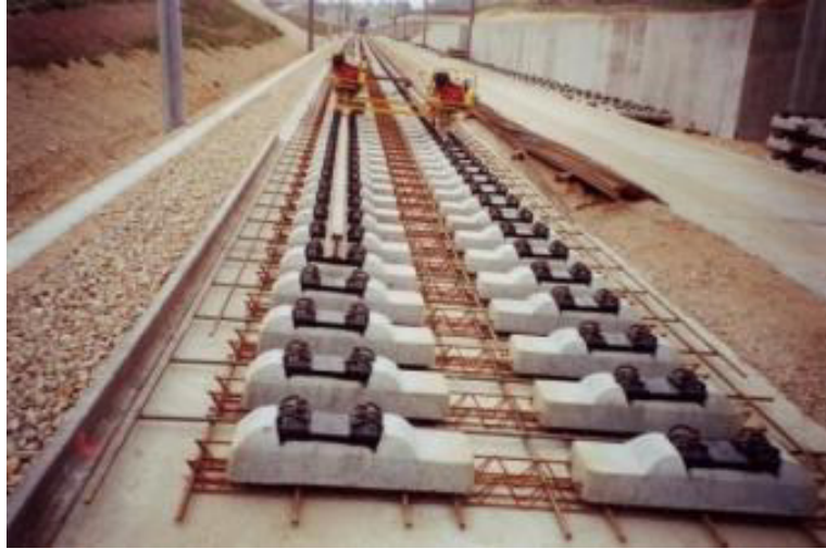
Şekil 2.8: Rheda-2000 inşaat aşamaları (beton öncesi) [4].
