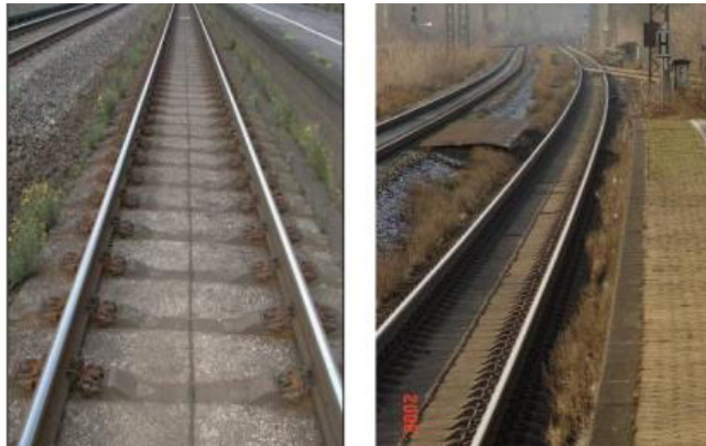
Şekil 2.7: 1972 yılında Rheda istasyonunda uygulanan üstyapı [4].
