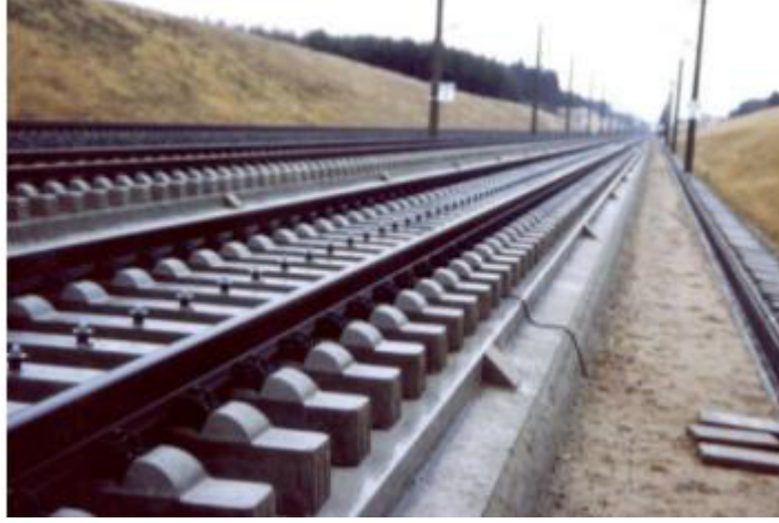
Şekil 2.18: BTD V2 üstyapı görüntüsü [4].
