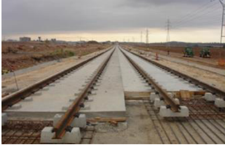
Şekil 2.9: Rheda-2000 inşaat aşamaları (beton sonrası) [4].
