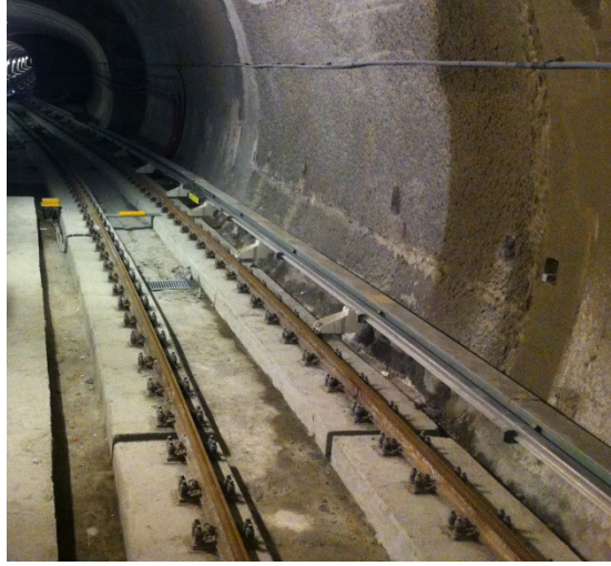
Şekil 3.19: Tünel içinde plinth betonlu üstyapı.
