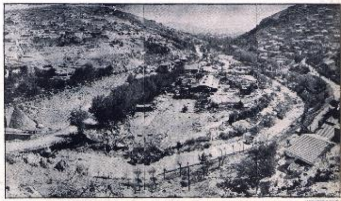
SELİN GEÇTİĞİ YERLER ÇAMURLA KAPLI. ENKAZIN KALDIRILMASI İÇİN ÇALIŞILIYOR.
