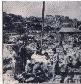
SELİN GEÇTİĞİ YERLER ÇAMURLA KAPLI. ENKAZIN KALDIRILMASI İÇİN ÇALIŞILIYOR.
