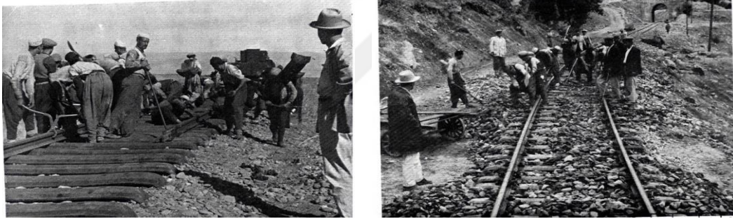
Görsel 4.24: Genç-Muş hattında işçiler inşaat için çalışmaktadır (Kaynak. CCA, Fon Kodu: 030.01.00.00. Yer No: 134.874.2.18).
