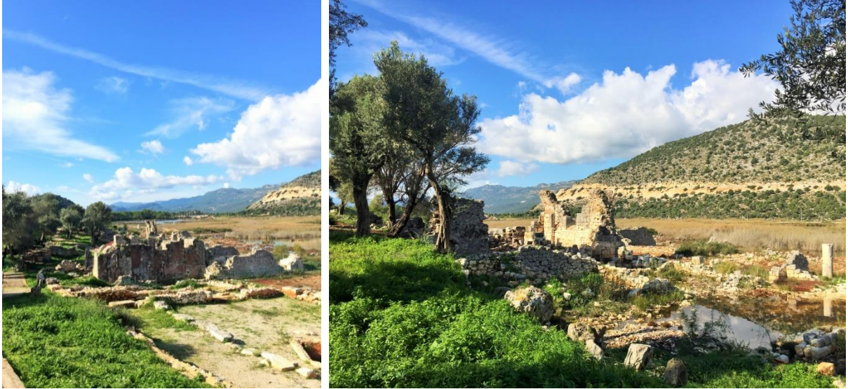
Fotoğraf 2.71-72. Andriake Limanı Hasar Görmüş Yapı Örnekleri
