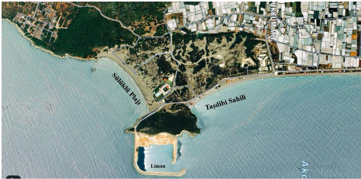
Şekil 2.2. İlçe Merkezine En Yakın İki Plaj (Taşdibi-Sülüklü) ve Yapım Aşamasındaki Yeni Liman (Google Haritalar, 2023)
