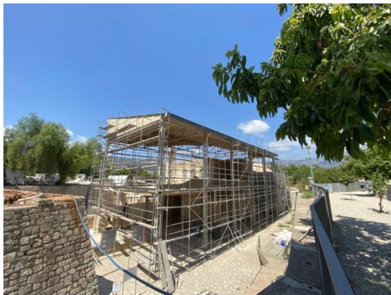
Fotoğraf 2.65. St. Nicholas Kilisesi Restorasyon Çalışması (2022)
