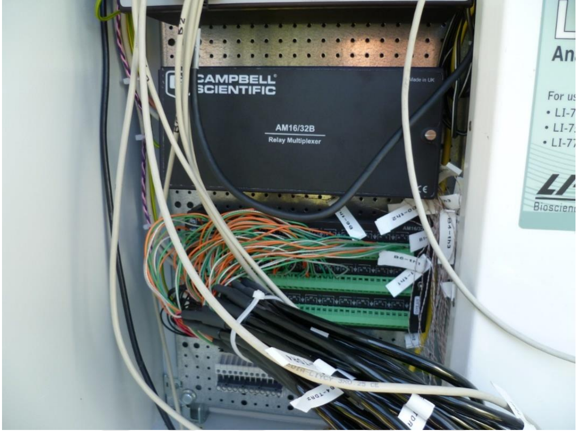
Şekil 2.18. Meteorolojik istasyondan alınan verileri depolayan CRX3000 datalog-ger Campbell scientific veri kayıt cihazı (Yılmaz vd., 2016)
