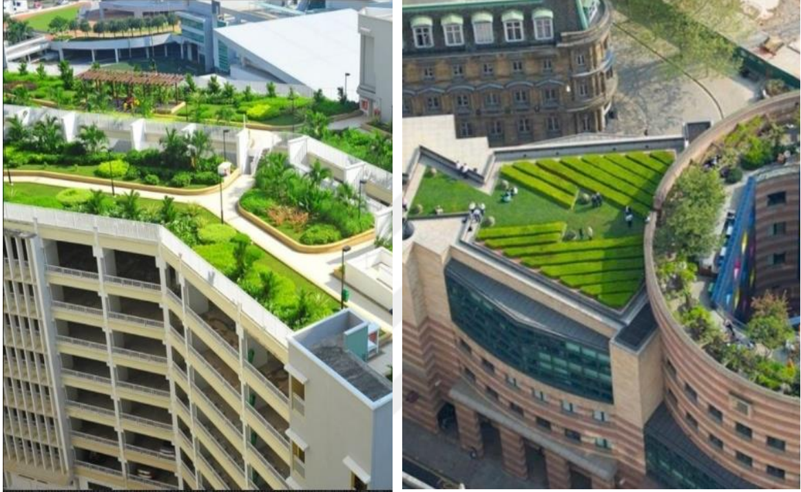
Şekil 1.2. Yoğun (intensif) yeşil çatı uygulanan binalarla ilgili görseller (URL-2, 2023 ve URL-3, 2023)
