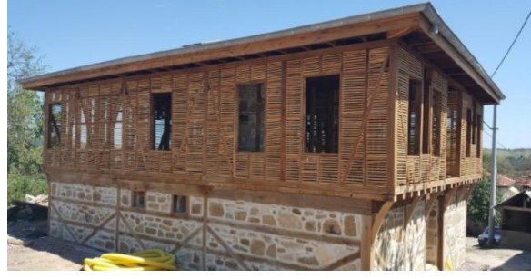
Şekil 1.13. Ahşap karkas sistemde bağdadi duvar tipi (URL-3).
