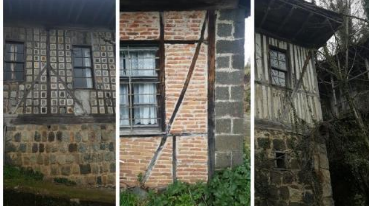
Şekil 1.9. Orta dikme, yan çalma ve köşe dikme detayları (Pınar, 2018).
