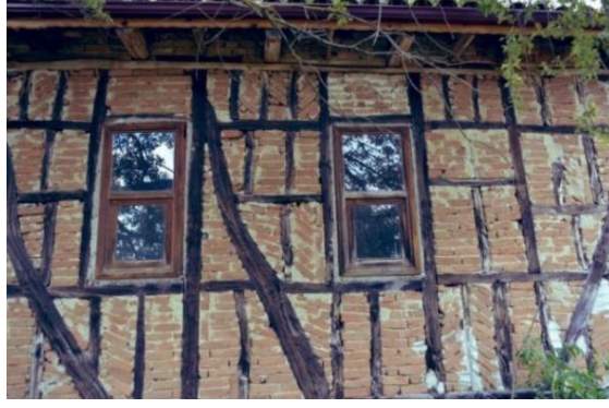
Şekil 1.12. Tuğla dolgu duvarlı ahşap karkas yapı kesiti (URL-4).
