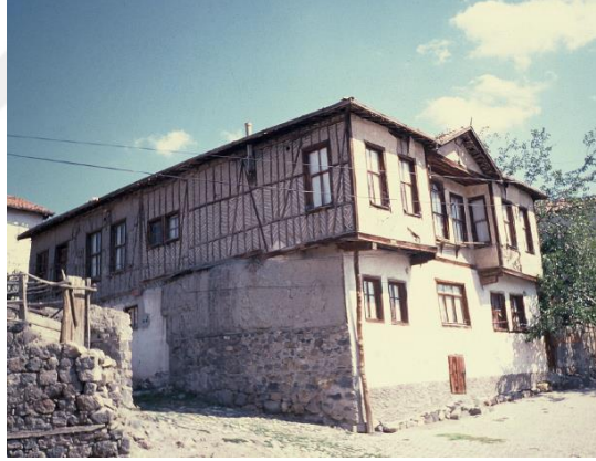
Şekil 1.11. Kerpiç blok dolgulu bir yapı (Işık, 2006).
