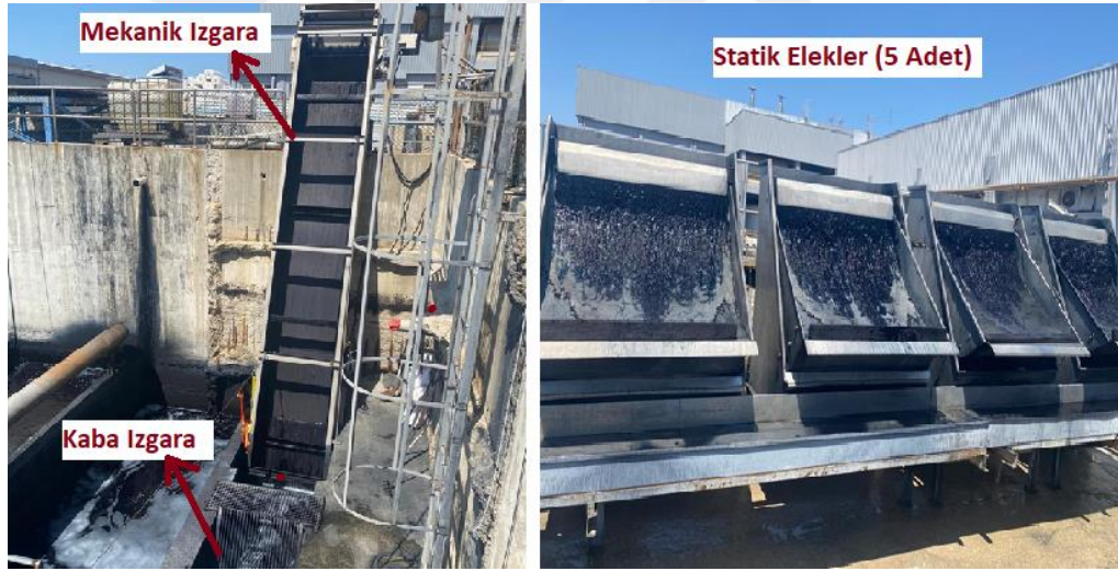
Şekil 4.79. Kaba Izgara, Mekanik Izgara ve Statik Elek
