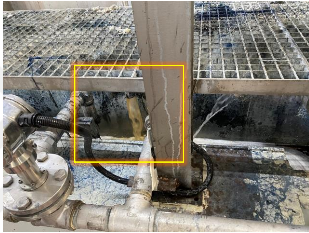
Şekil 4.15. Merserize Sonrası Yıkama Atıksuyu Deşarj Noktası
