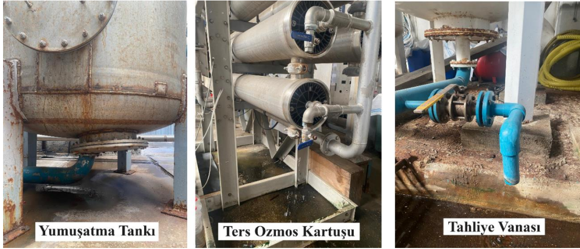
Şekil 4.29. Su Kaçaklarının Tespit Edildiği Noktalar
