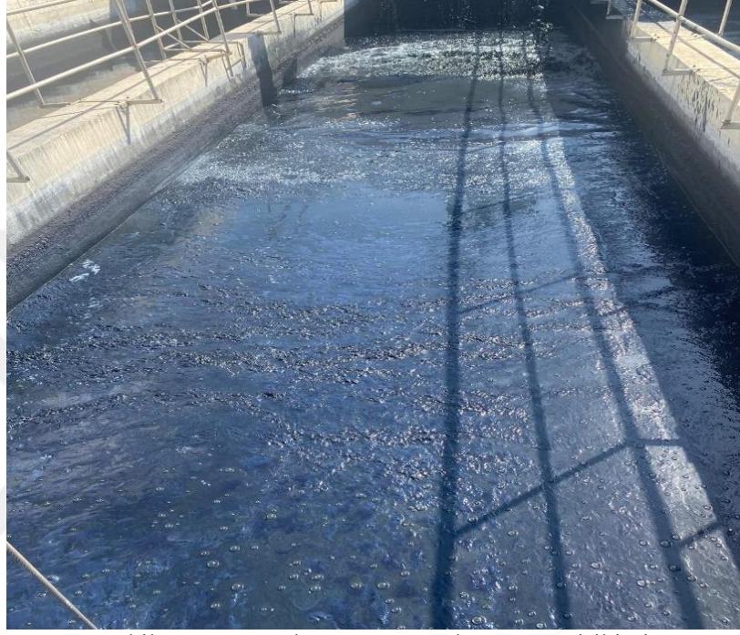
Şekil 4.81. Dengeleme Havuzunda Çamur Birikimi
