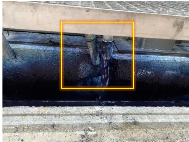
Şekil 4.16. Boyama Sonrası Yıkama Atıksuyu Deşarj Noktası
