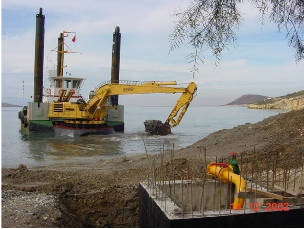
Şekil 3.6 Deniz deşarjı inşaatında kazı çalışması.
