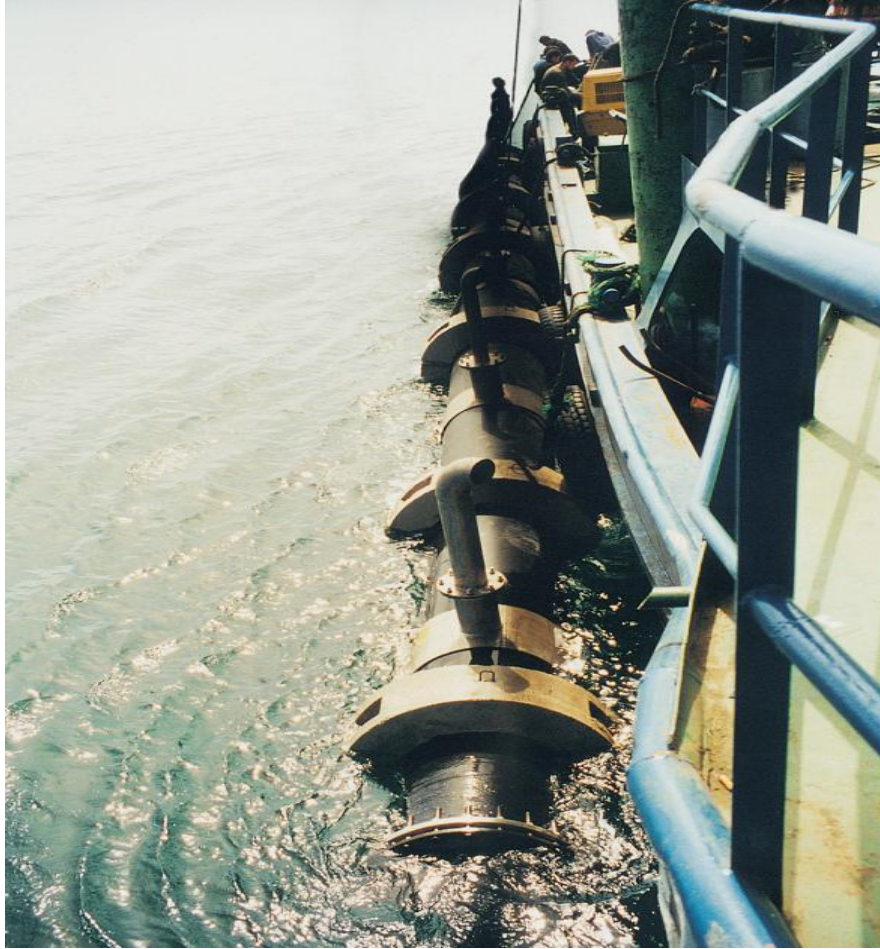
Şekil 3.11 Difüzörün batırılması.
