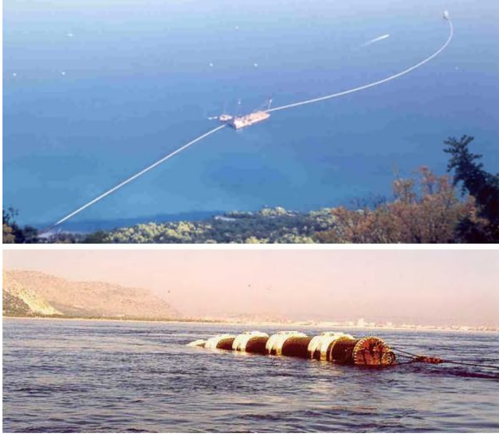
Şekil 3.10 Deniz deşarj hattının güzergahına getirilmesi ve batırılması.
