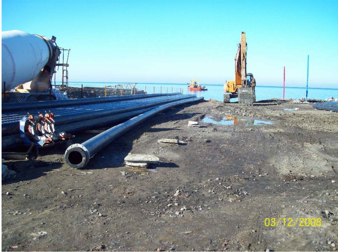
Şekil 3.8 Anoların şantiyede istiflenmesi
