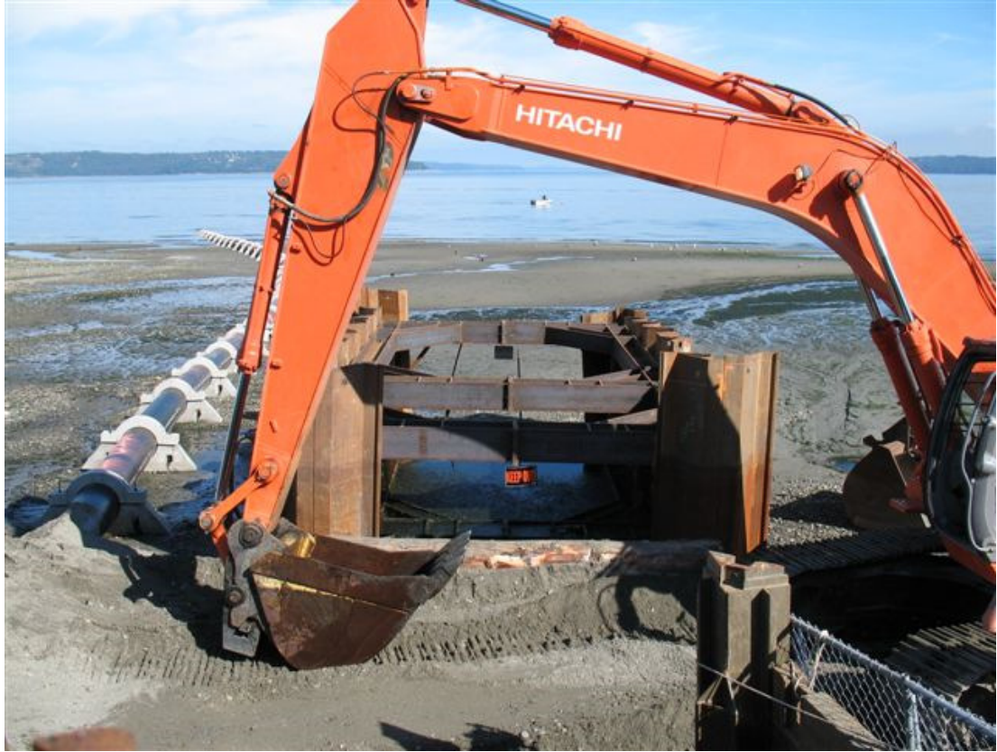
Şekil 3.12 Kara kesiminde yapılan şantiye çalışmaları.
