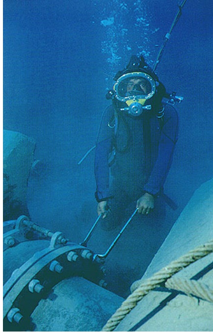
Şekil 3.13 Deniz deşarjında şantiyesinde dalgıç çalışması
