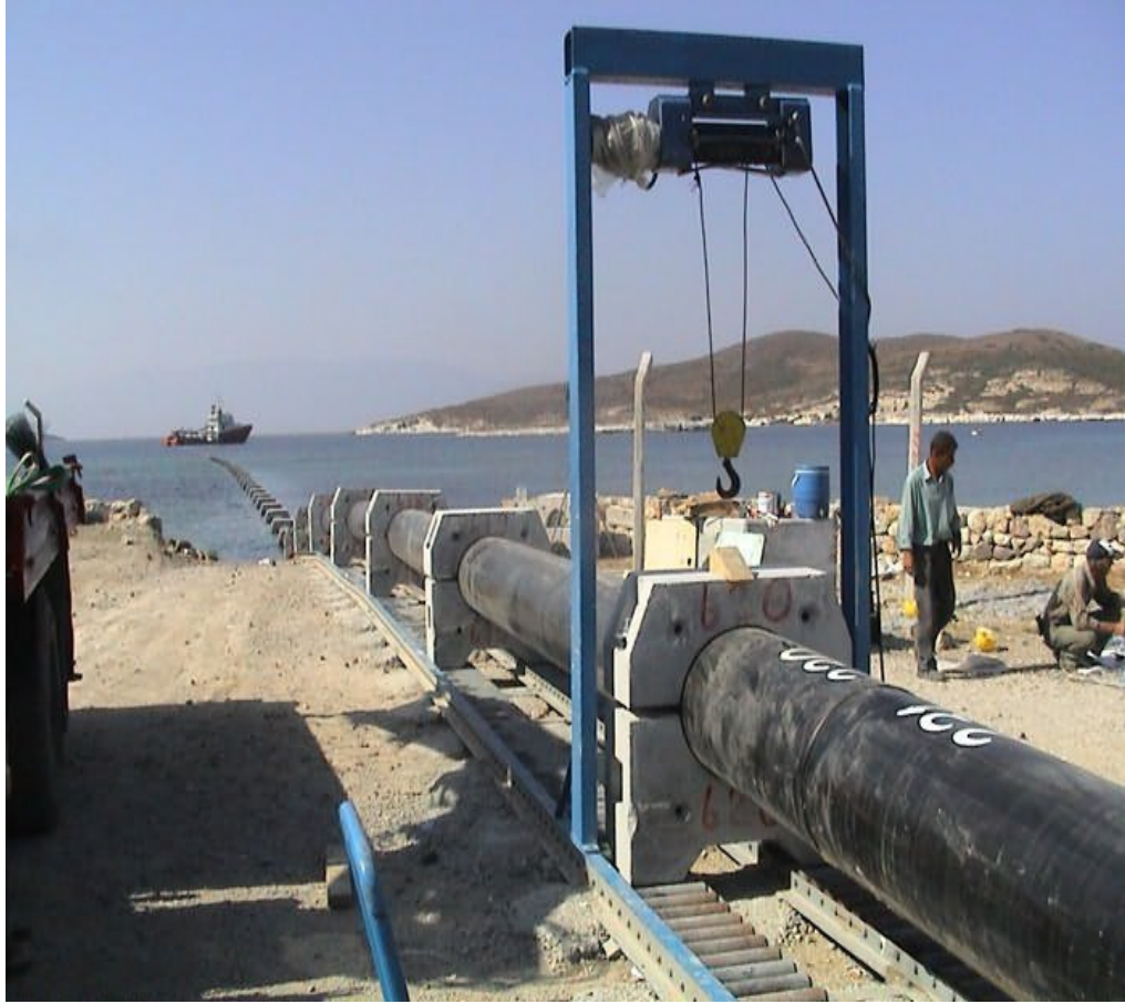
Şekil 3.9 Anoların birleştirilerek denize indirilmesi.
