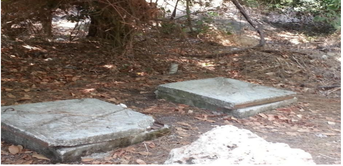
Şekil 4.2. Foseptik çukuru kapakları
