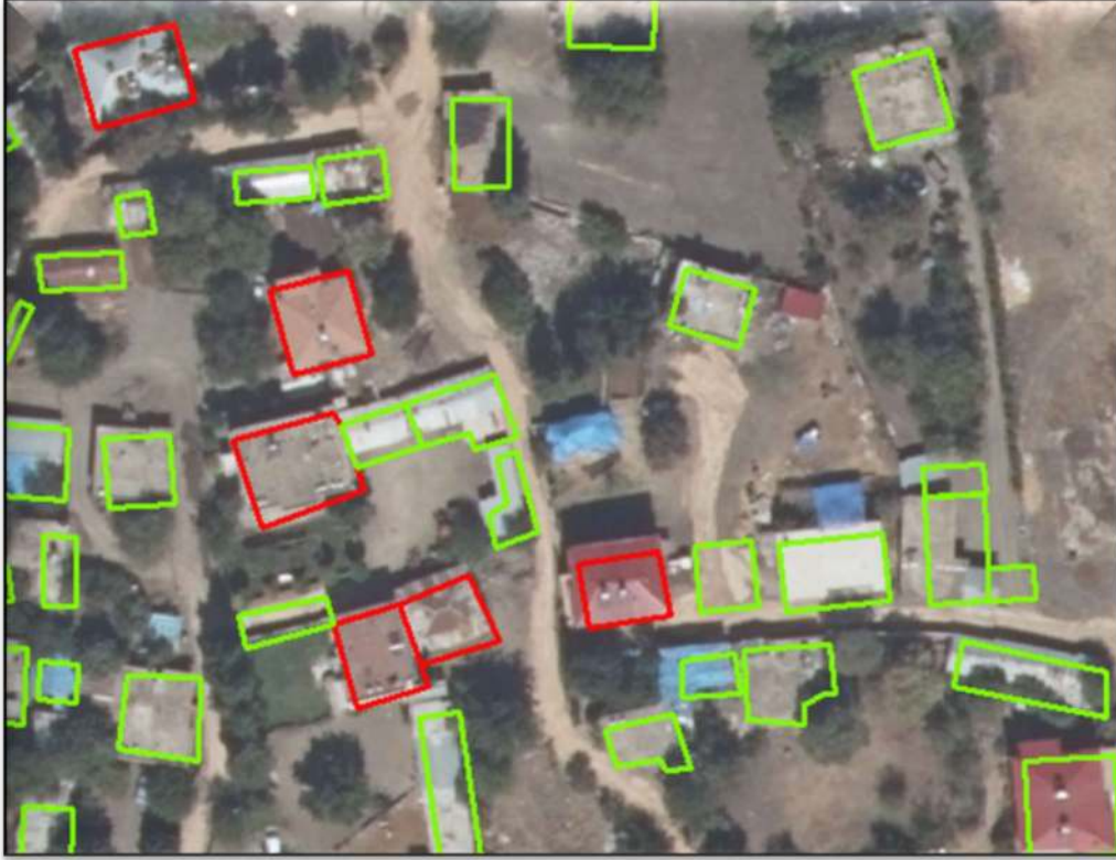
Şekil 4.18 Yıkılan ve Yıkılmayan Binaların Birlikte Görünümü (dö-GÖR).
