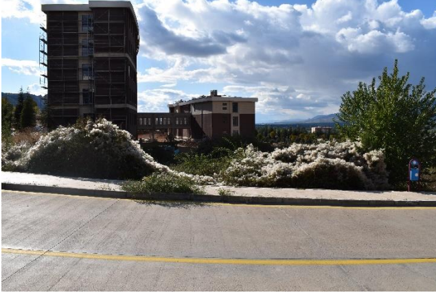
Şekil 2. 10. Yeni Rektörlük Binası İnşaatı (Orijinal,2024)
